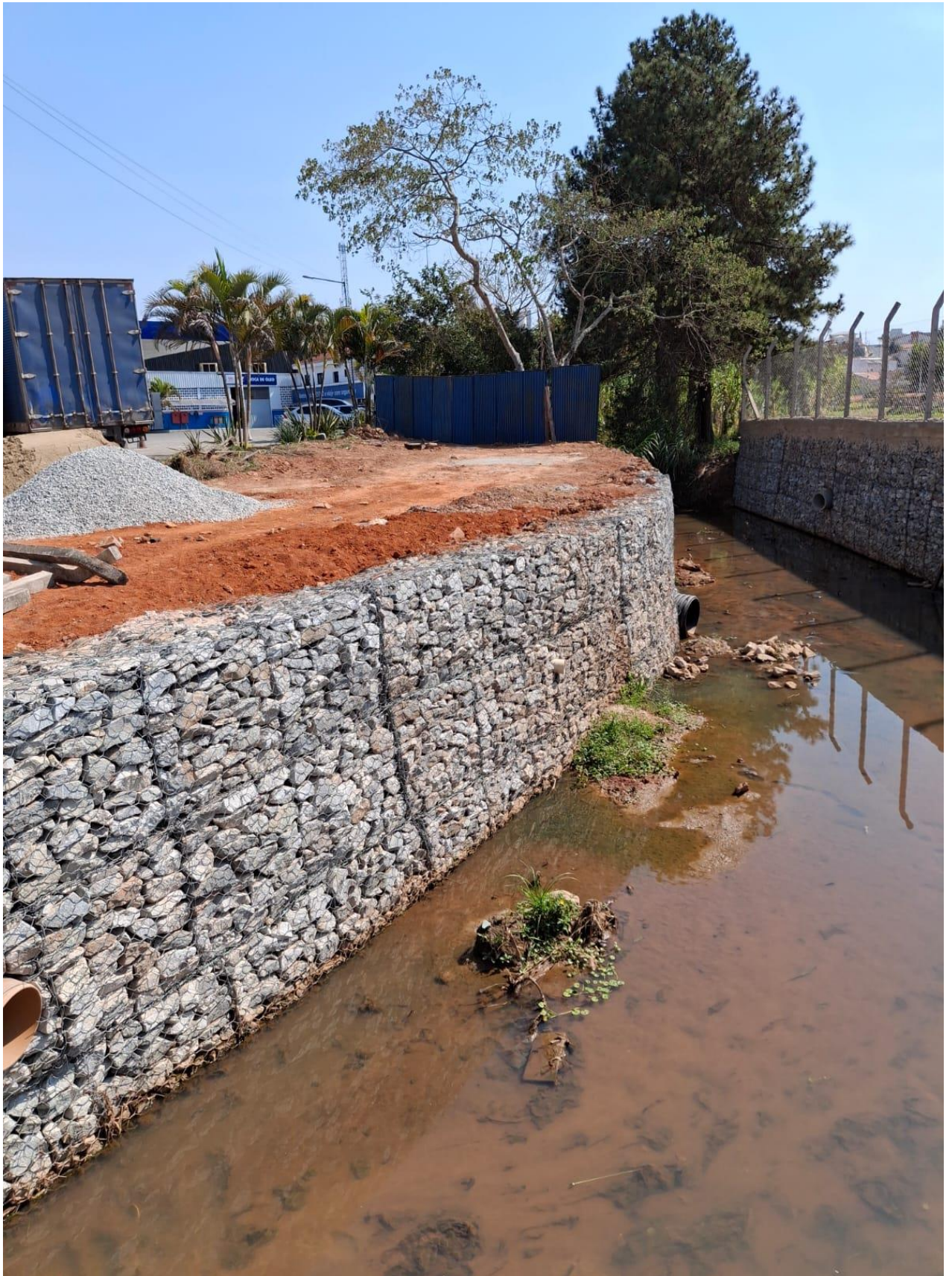
Figura 26 – Descarte pluvial na margem direita
