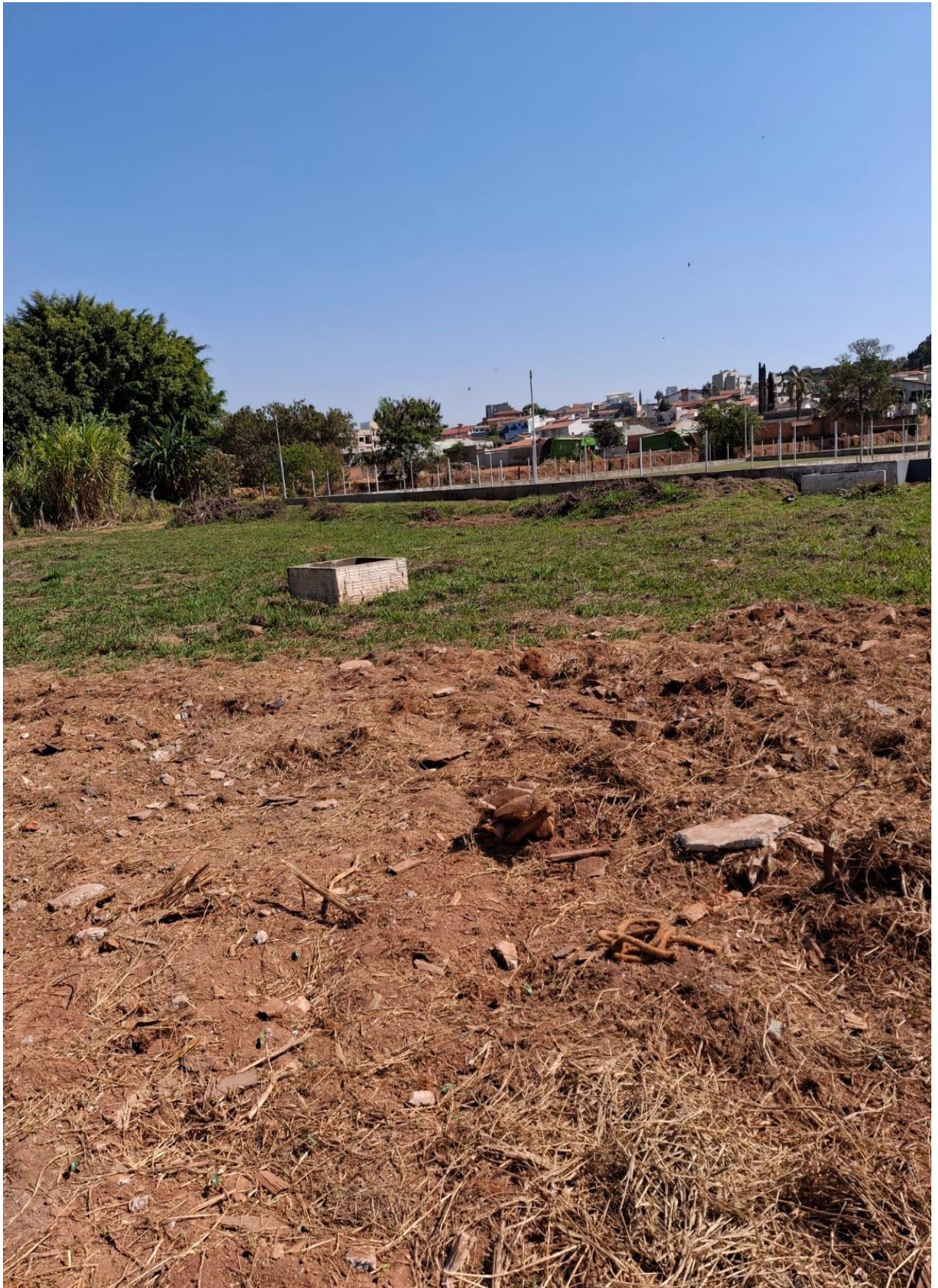
Figura 17 – Caixa de passagem pluvial na margem esquerda
