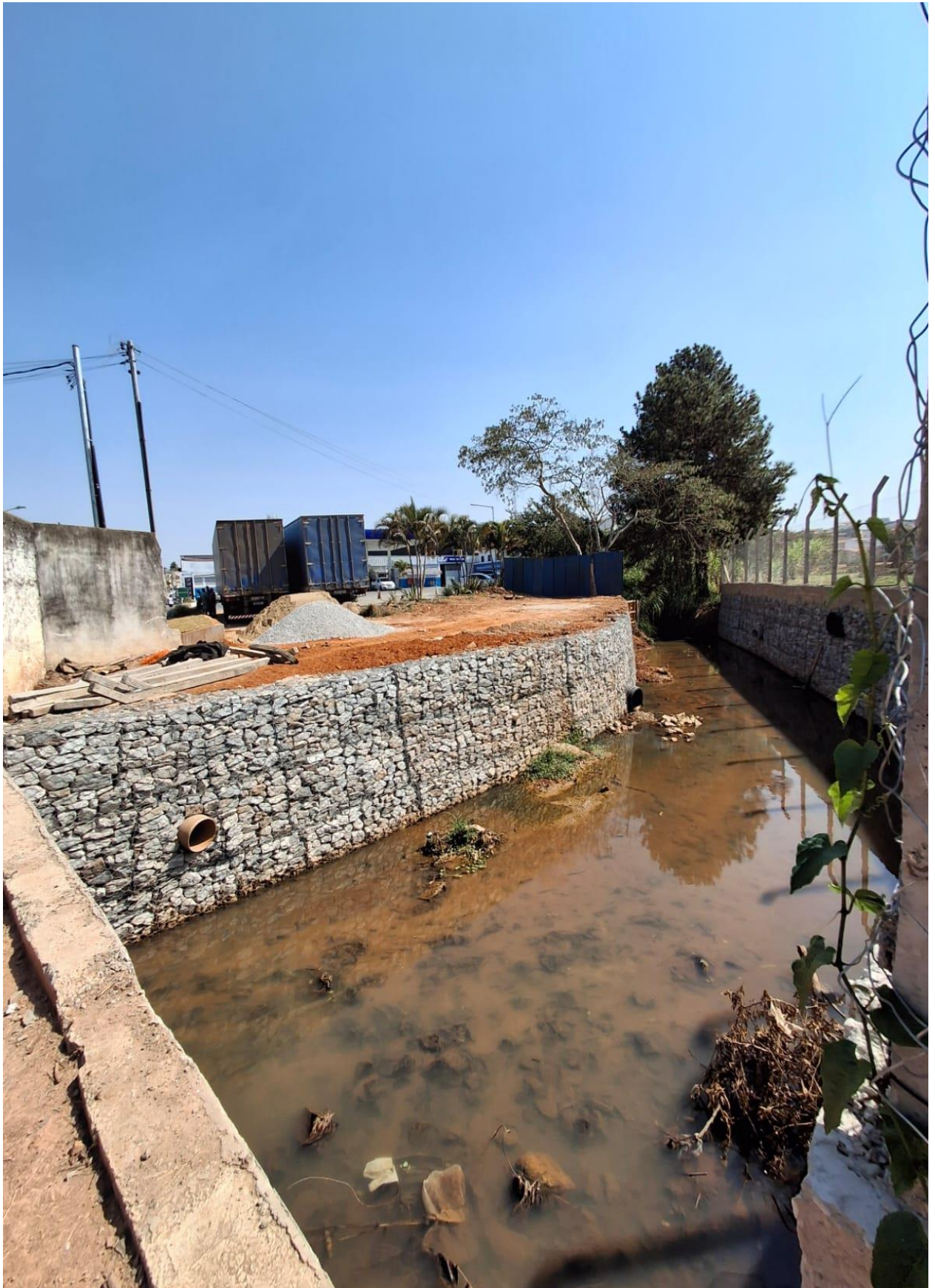
Figura 20 – Vista da margem direita
