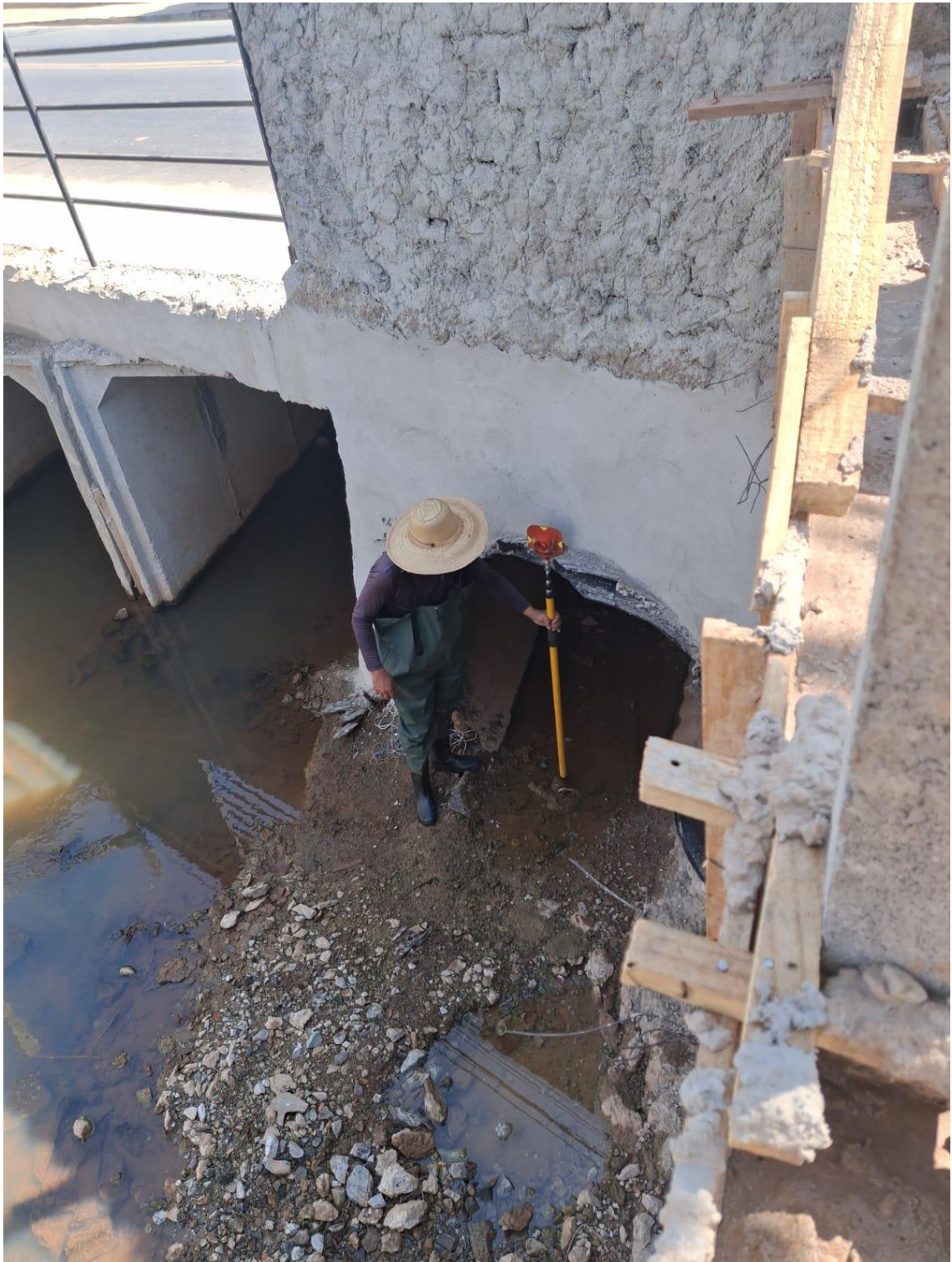
Figura 32 – Coleta de cota fundo de saída do bueiro tubular
