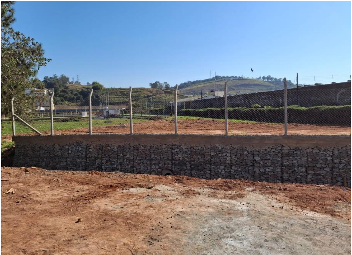
Figura 9 – Vista da margem esquerda próximo ao início da canalização
