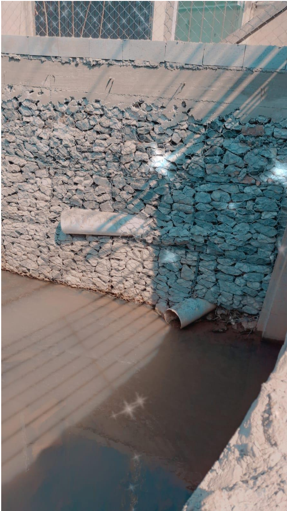
Figura 50 – Descarte pluvial na margem direita
