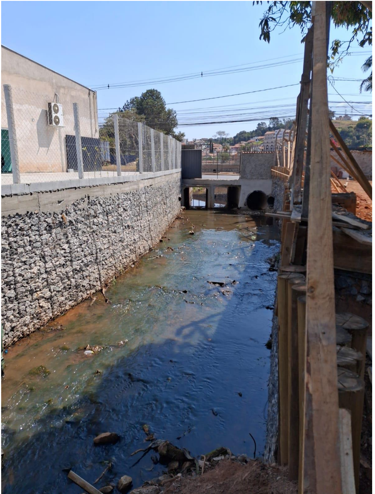
Figura 45 – Vista da margem direita
