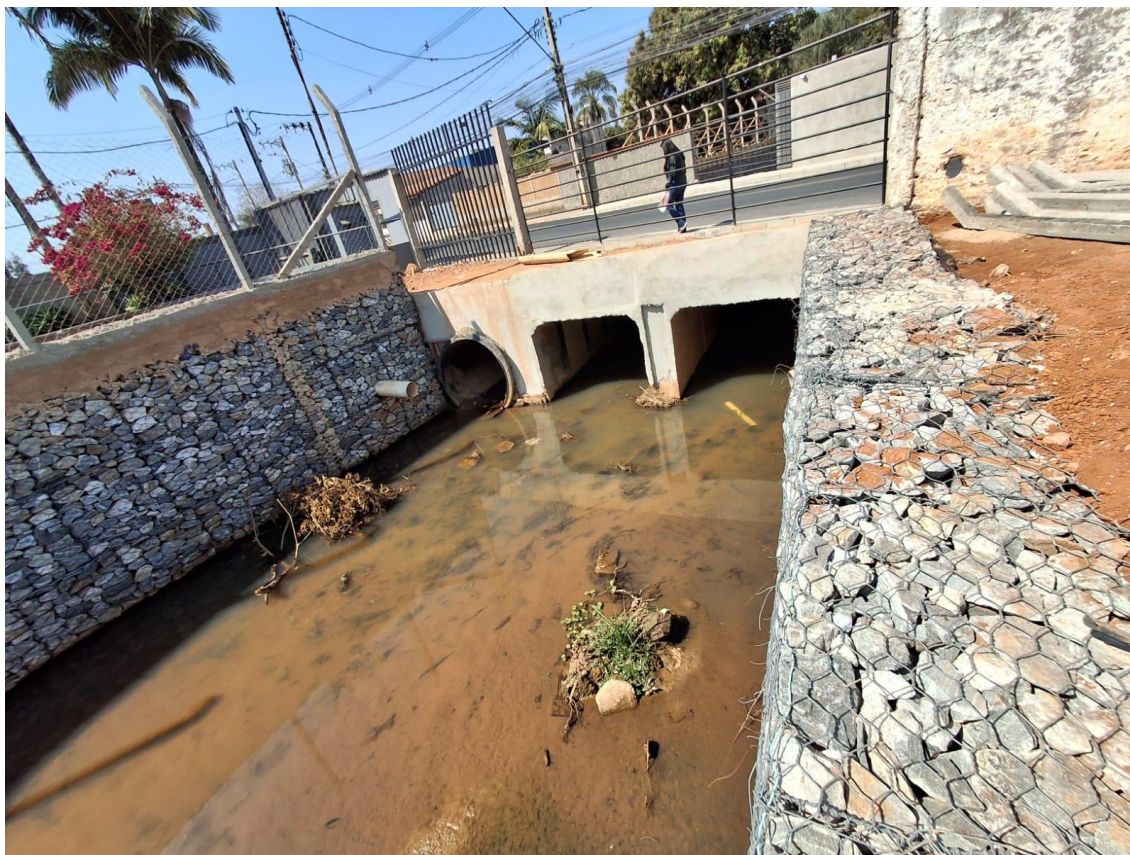
Figura 28 – Vista da entrada da travessia
