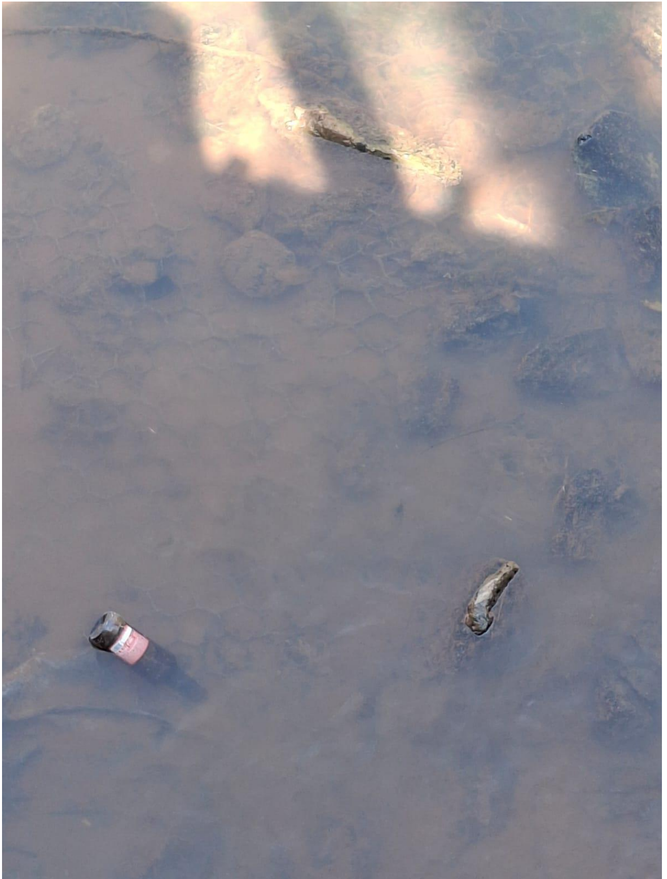
Figura 52 – Gabião colchão reno no leito do curso d'água
