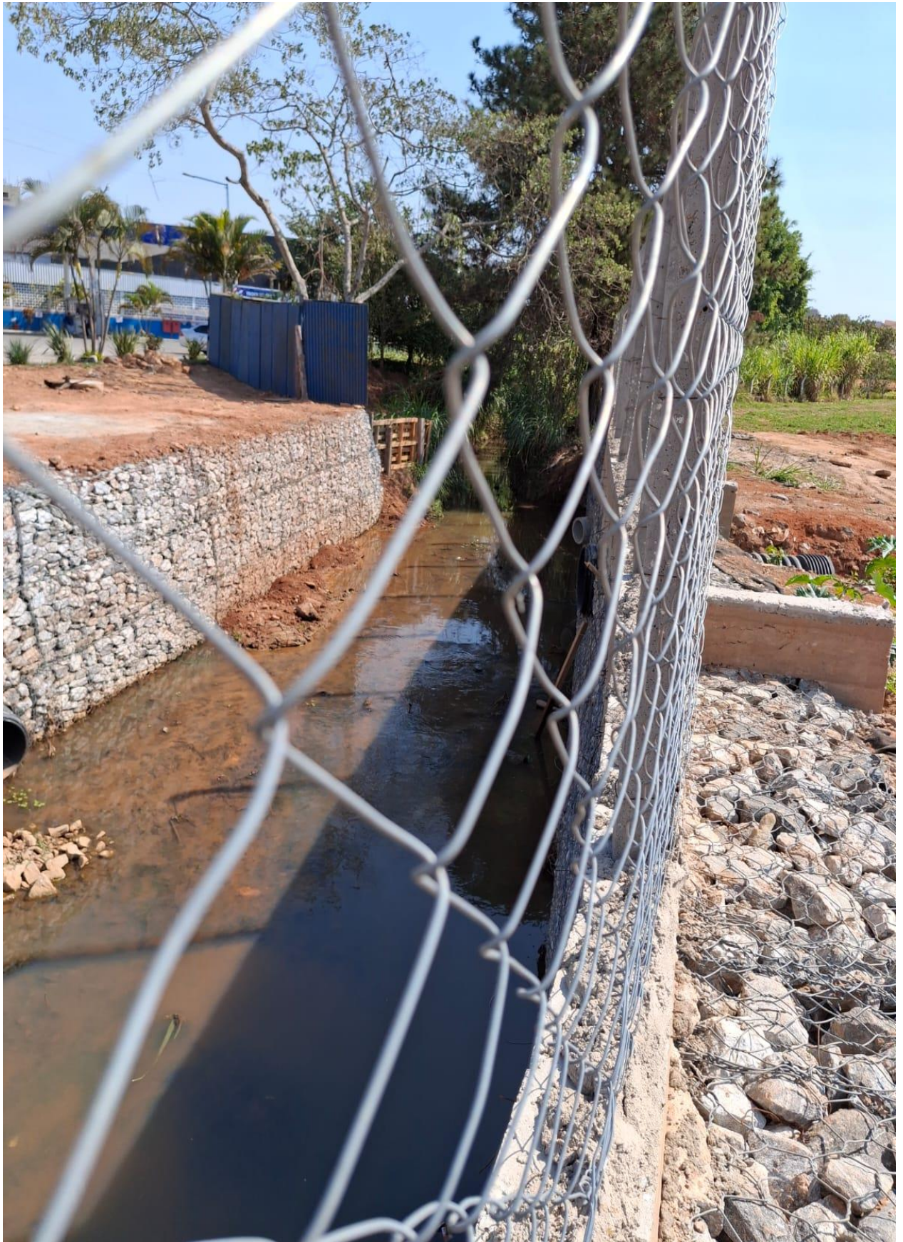
Figura 21 – Vista da margem direita próximo ao início da canalização
