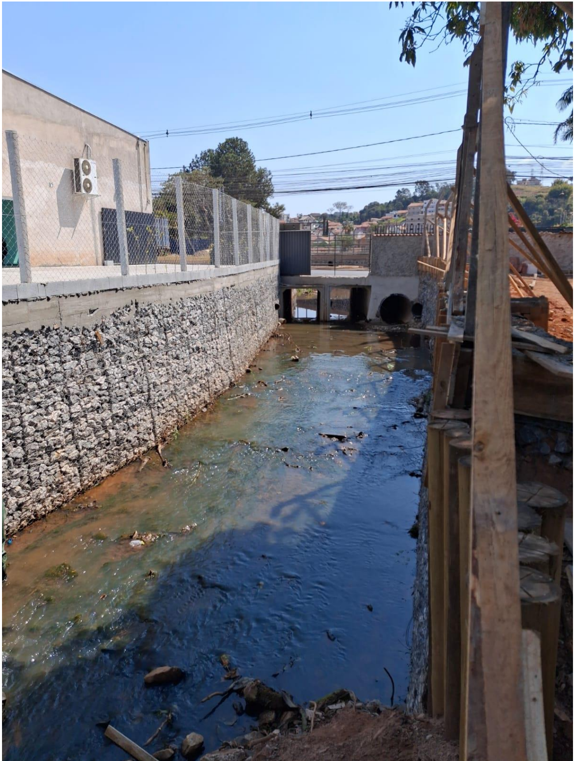
Figura 29 – Vista da saída da travessia
