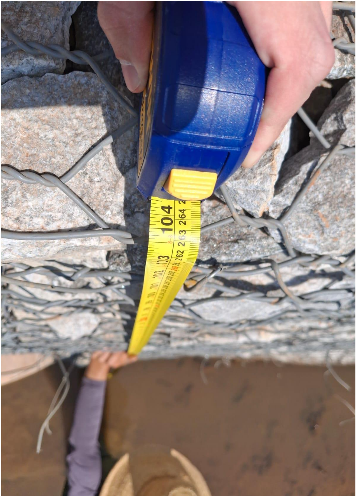
Figura 27 – Medição da altura da parede de gabião na margem direita
