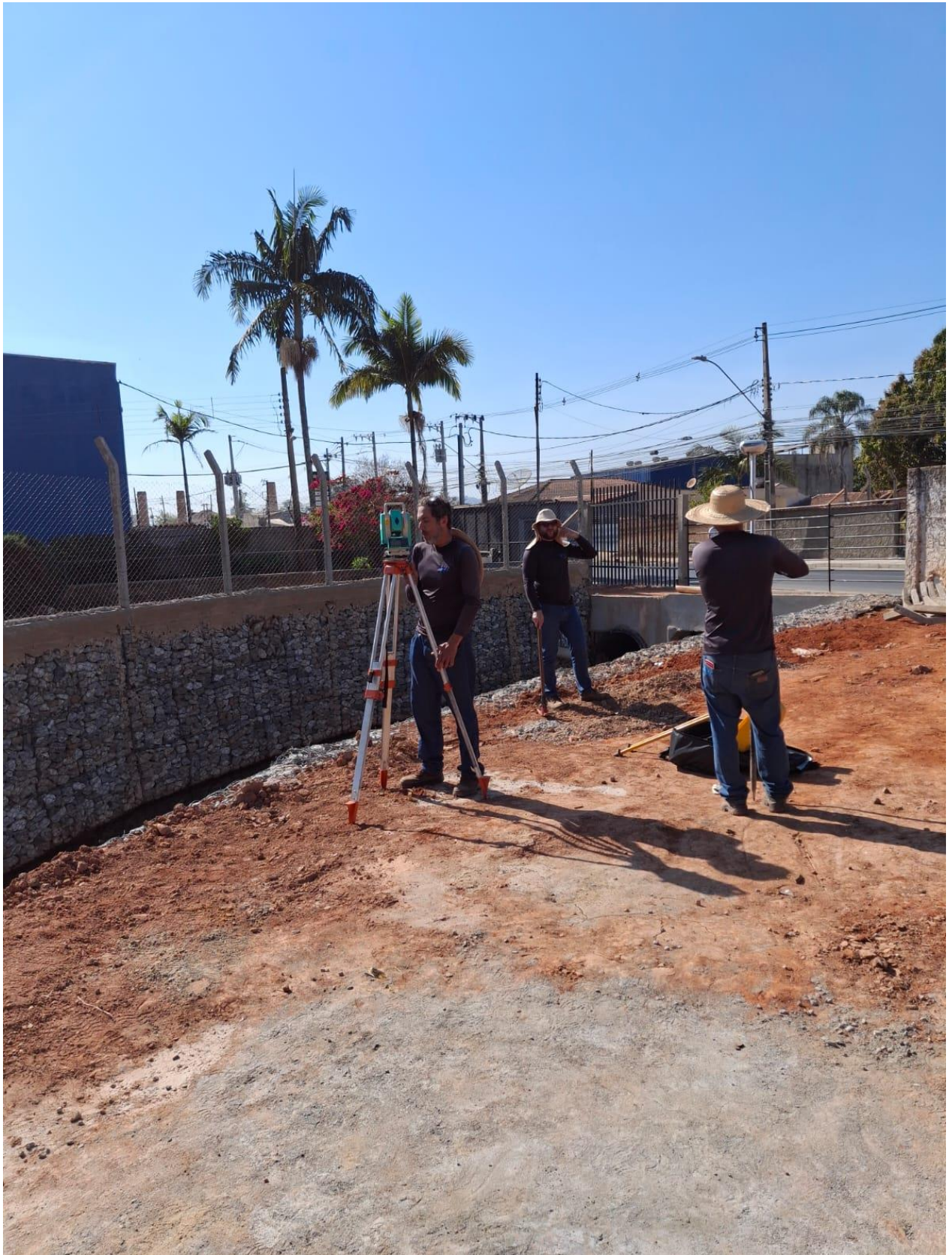
Figura 2 – Montagem dos equipamentos para coleta de dados com estação total
