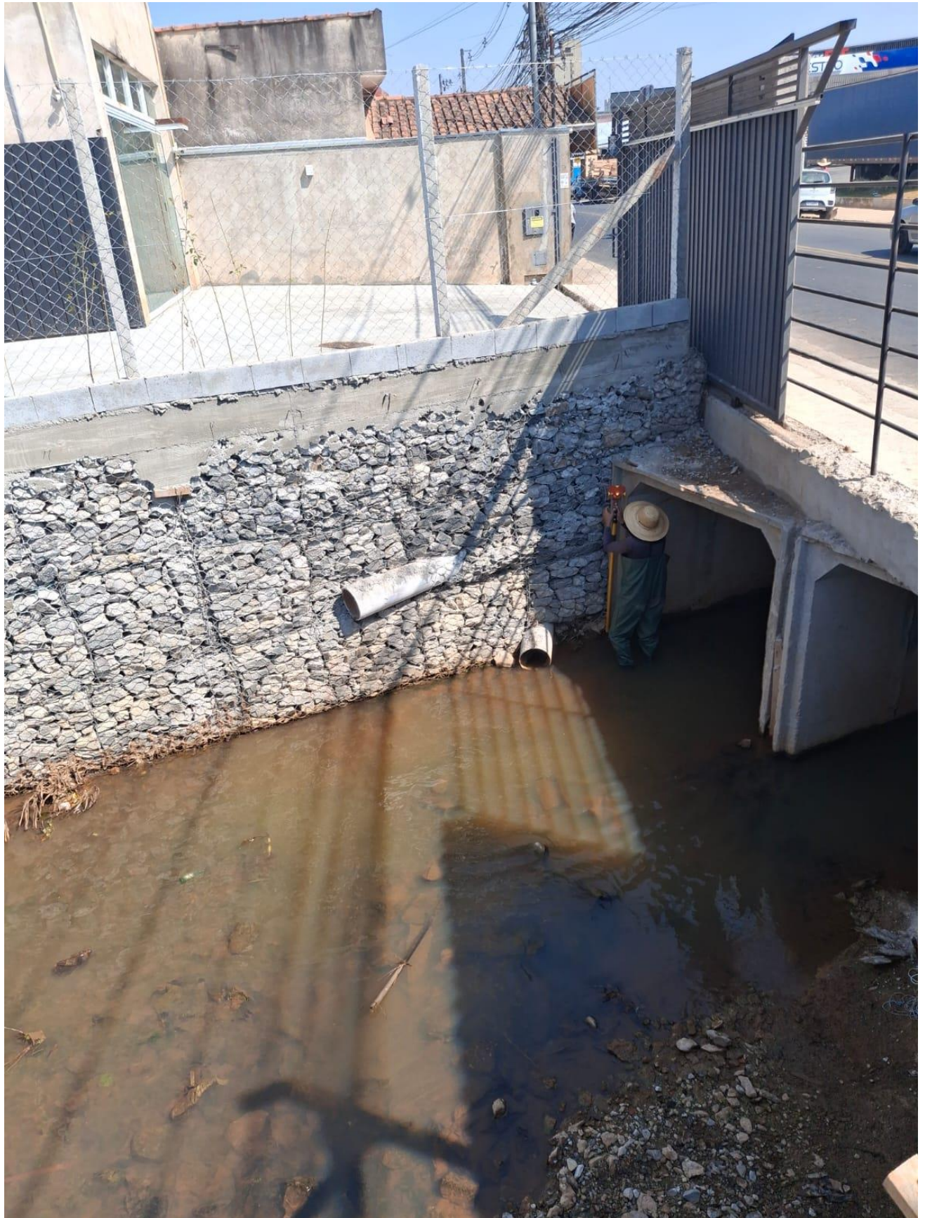
Figura 40 – Coleta de cota no início do trecho
