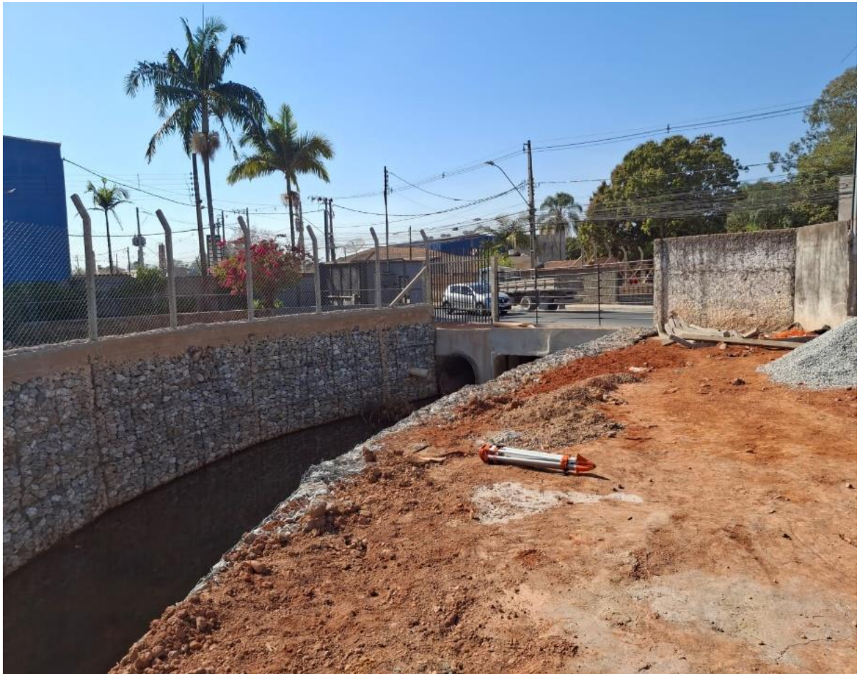
Figura 10 – Vista da margem esquerda próximo ao início da travessia aérea
