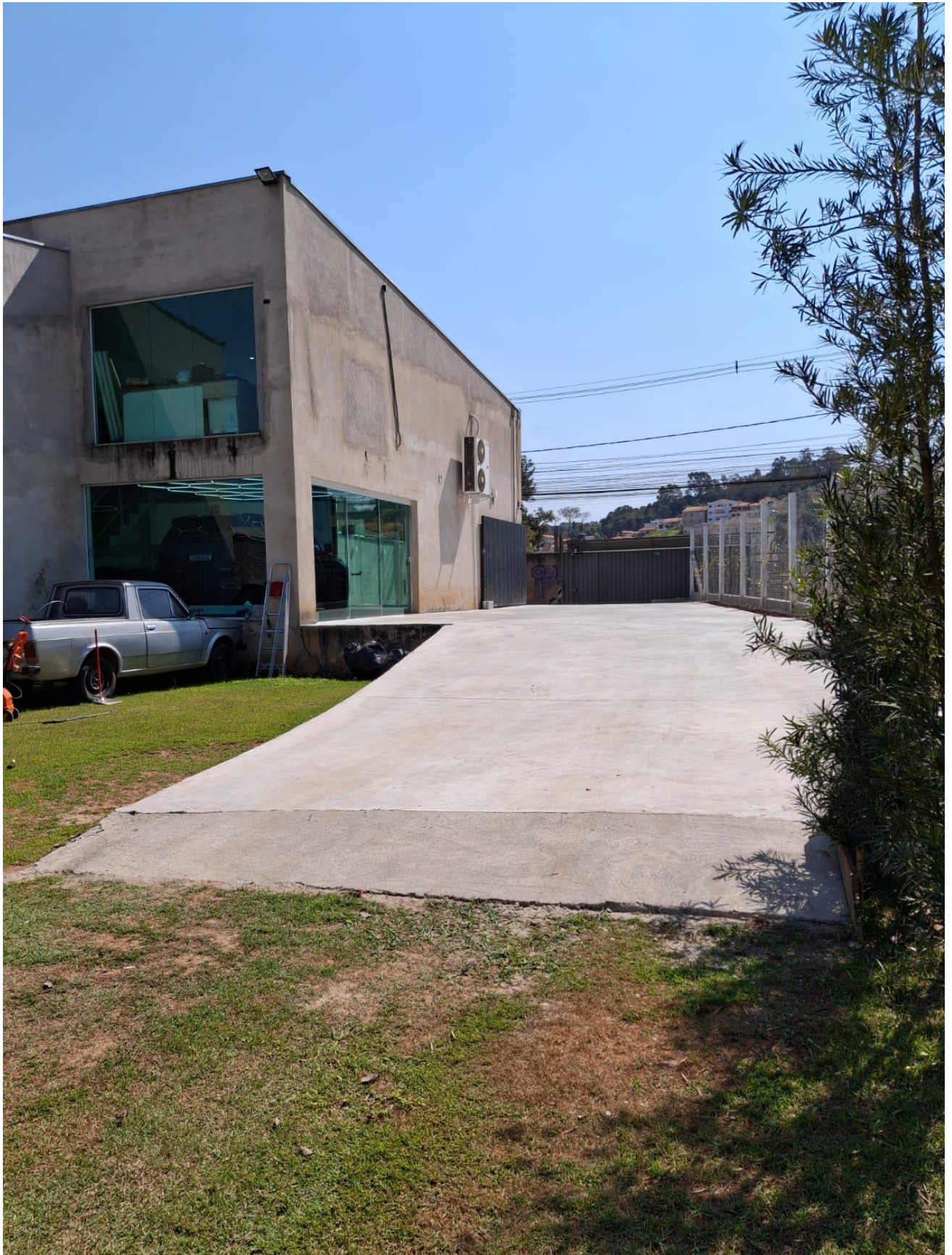
Figura 49 – Situação da margem direita no dia do levantamento
