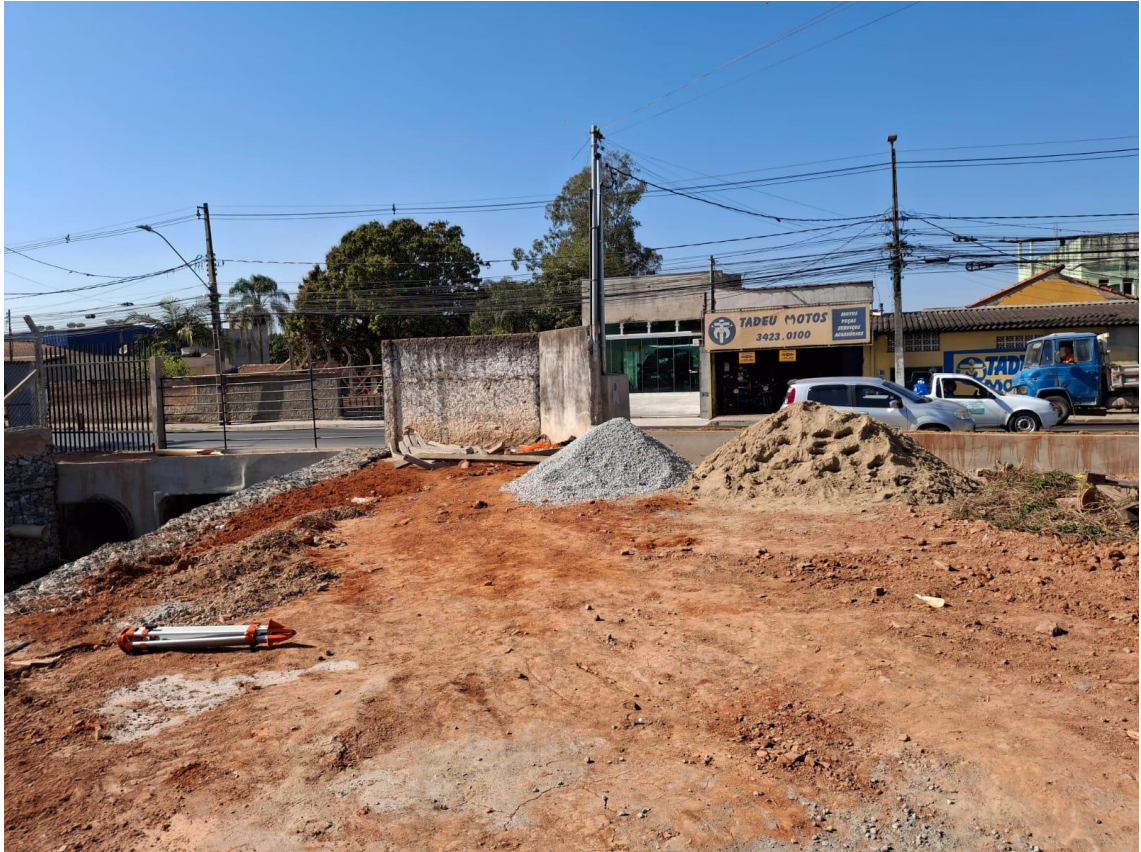
Figura 23 – Situação da margem direita no dia do levantamento
