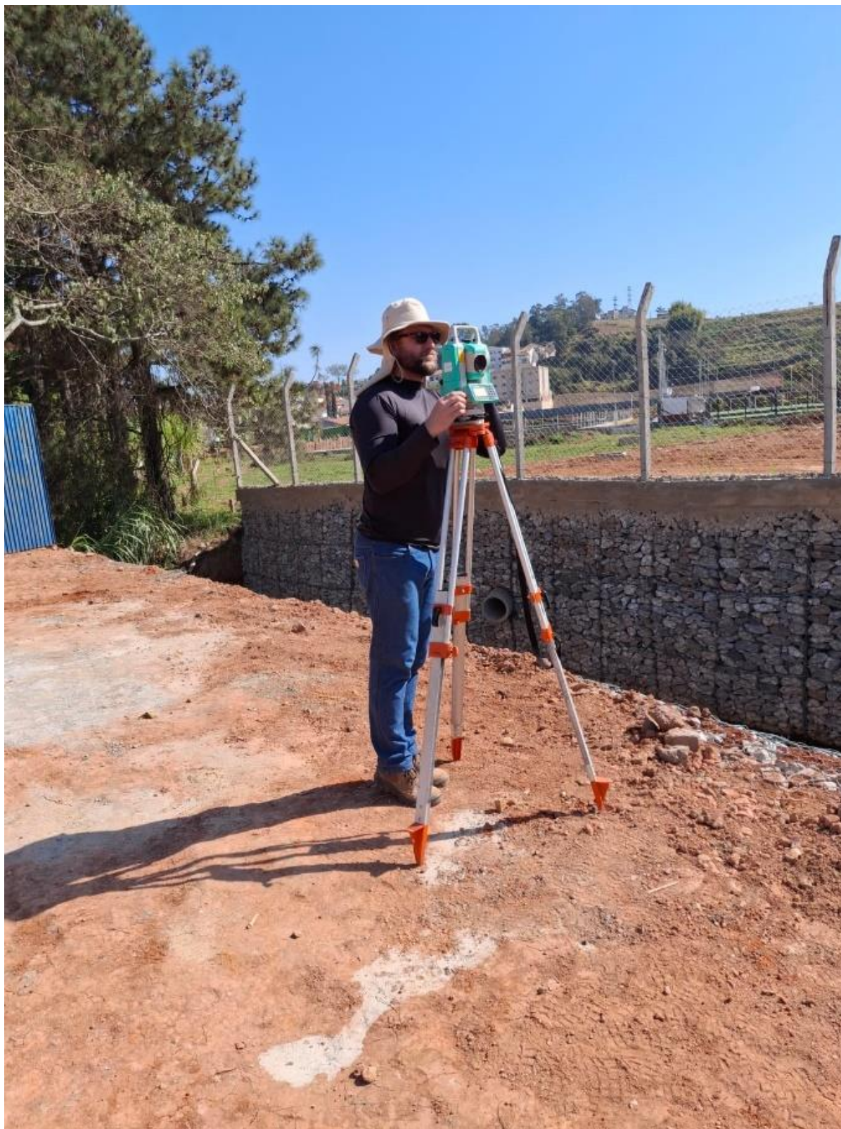
Figura 1 – Montagem dos equipamentos para coleta de dados com estação
