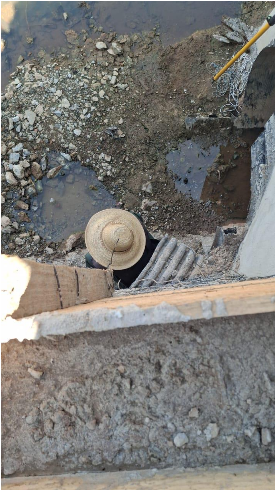
Figura 39 – Vista superior do descarte pluvial na margem esquerda
