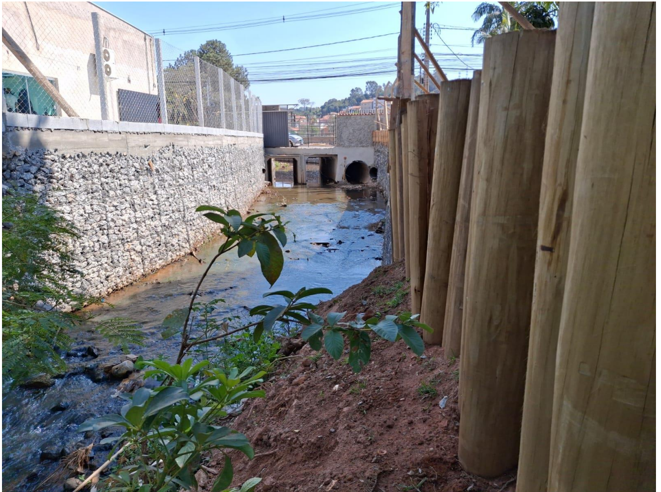
Figura 46 – Vista da margem direita
