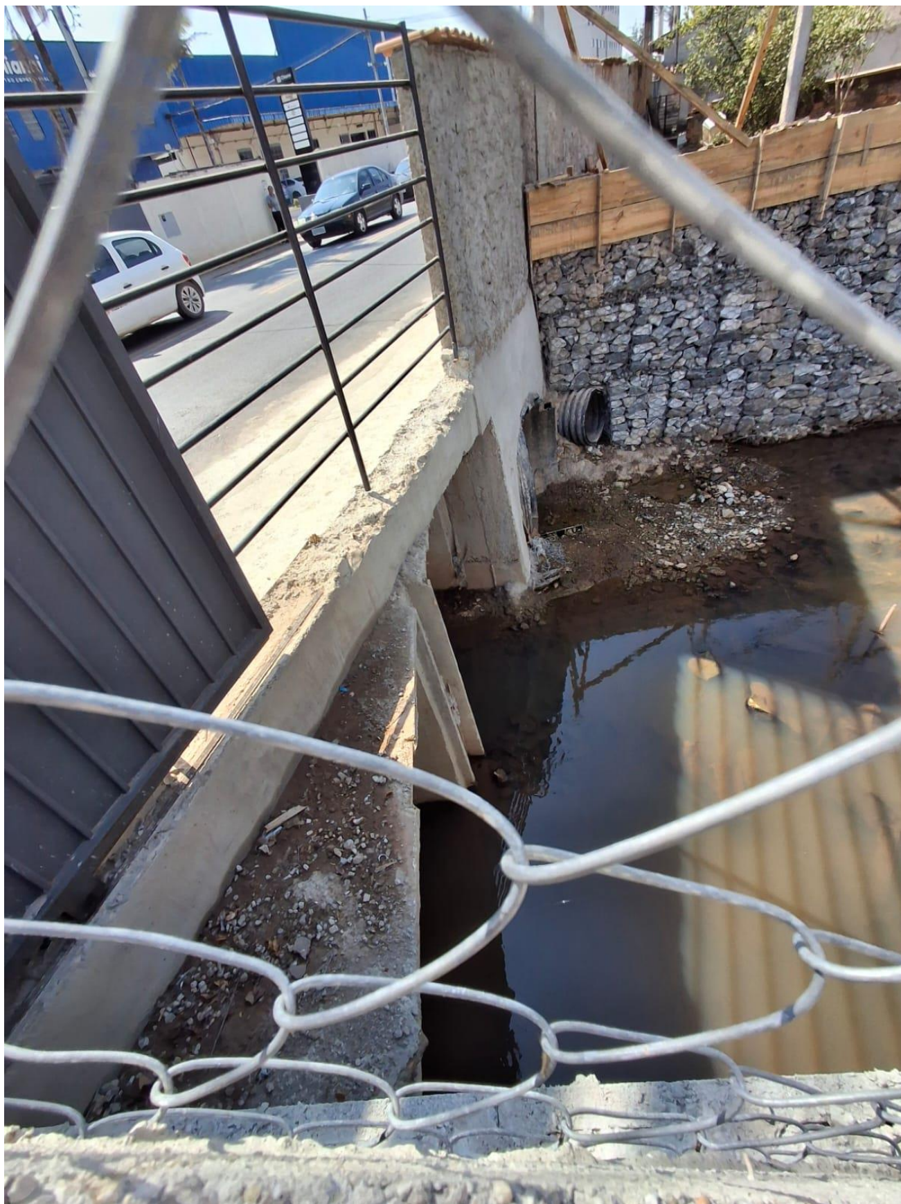
Figura 37 – Vista da margem esquerda próxima ao início da canalização
