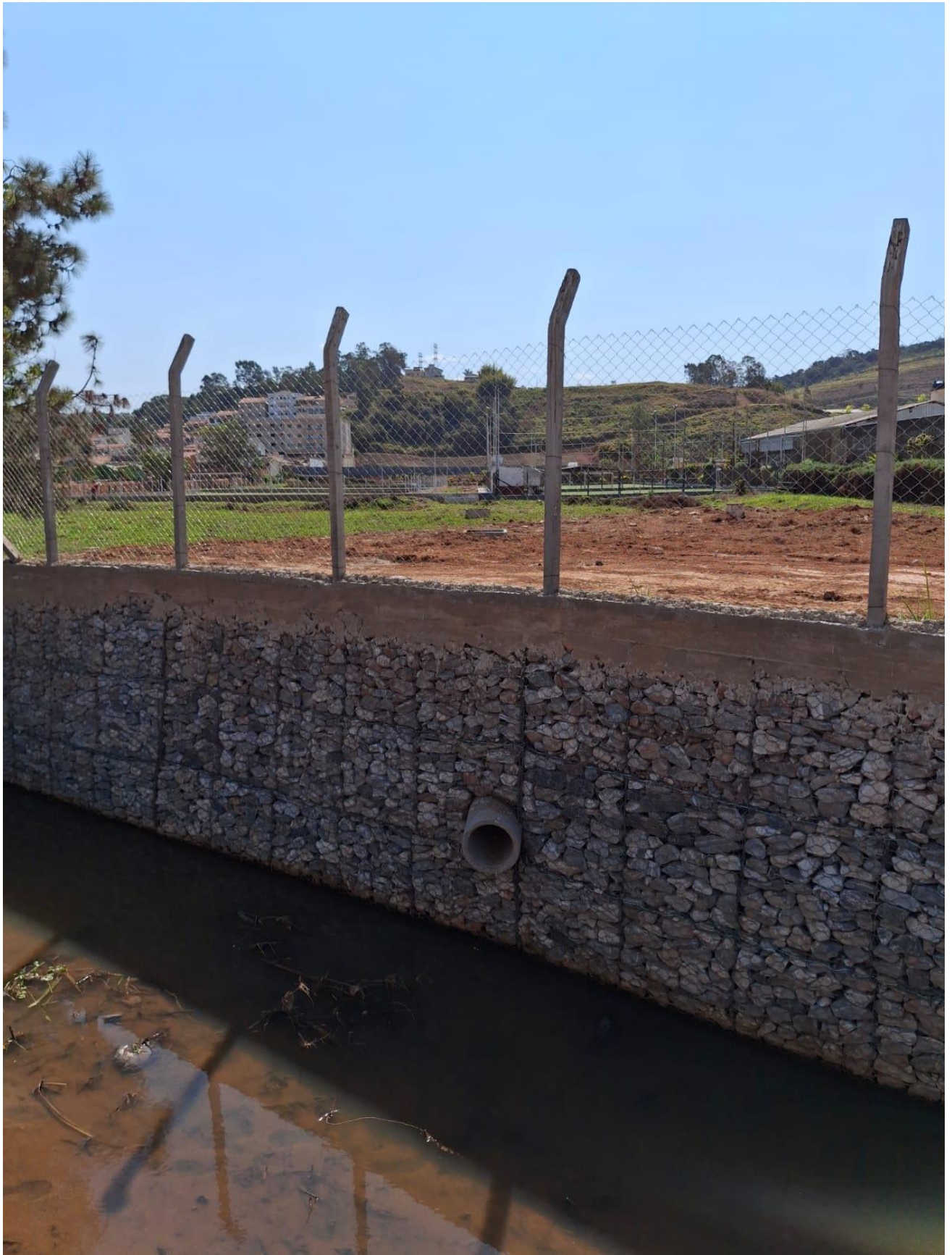
Figura 12 – Descarte pluvial na margem esquerda
