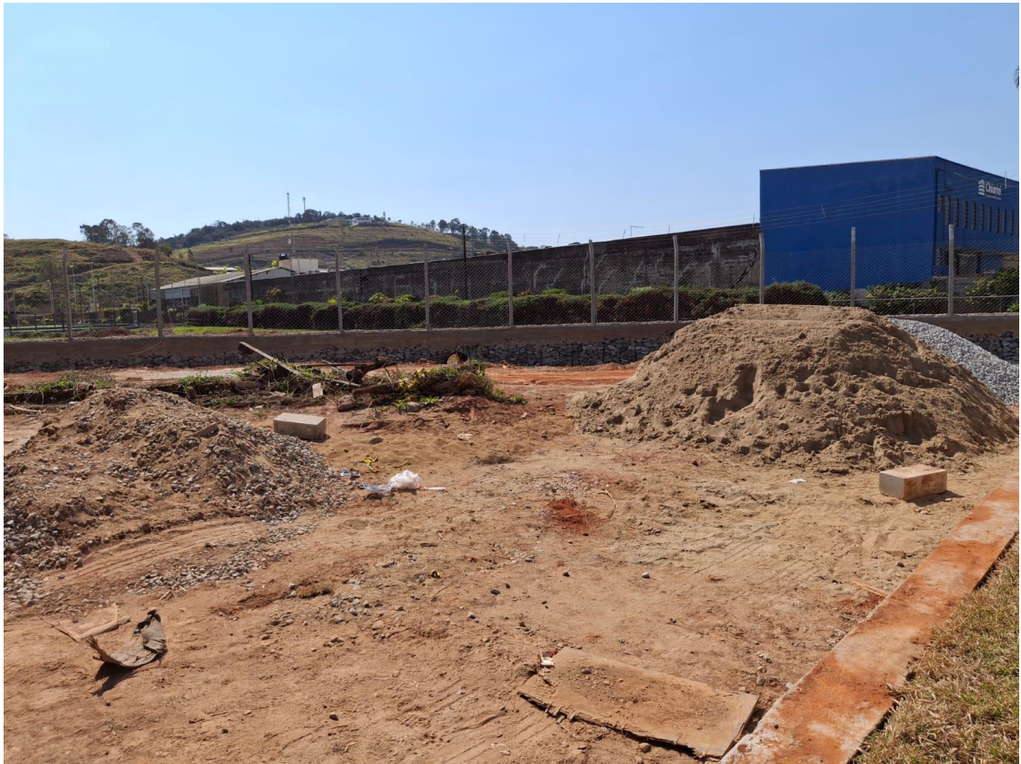
Figura 25 – Situação da margem direita no dia do levantamento
