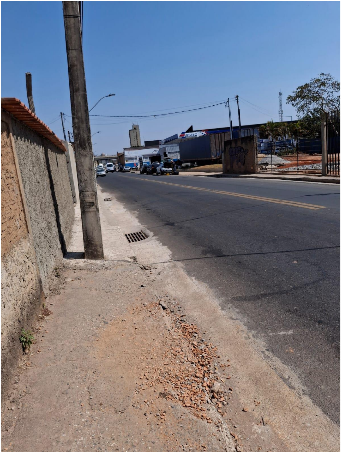
Figura 34 – Bocas de lobo sobre a travessia
