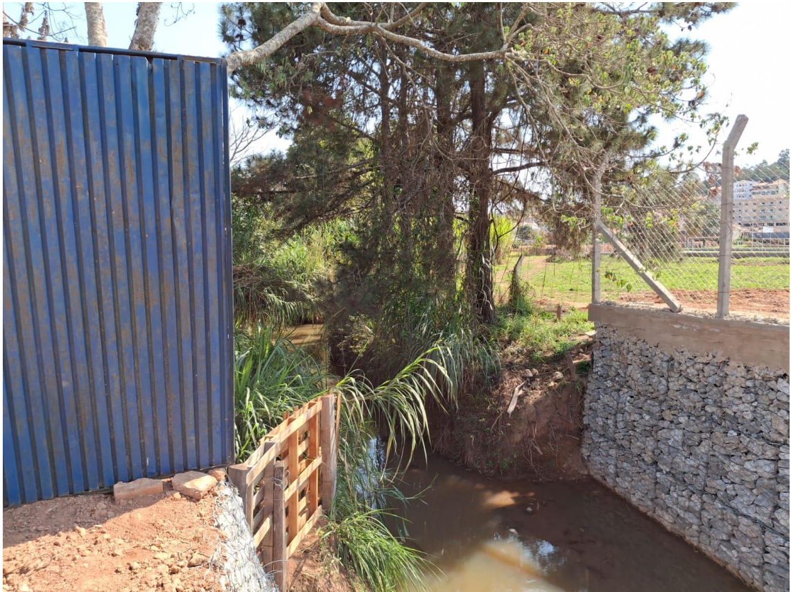
Figura 6 – Transição entre o canal natural e o início da canalização em gabião
