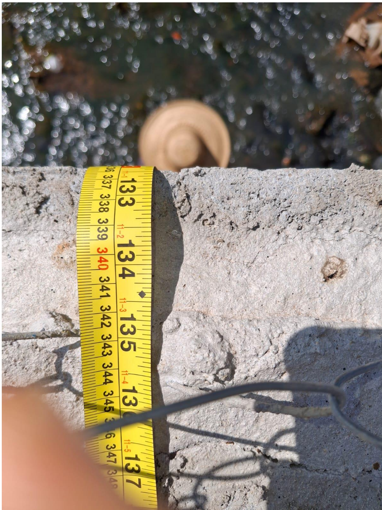
Figura 51 – Medição da altura da parede de gabião na margem direita
