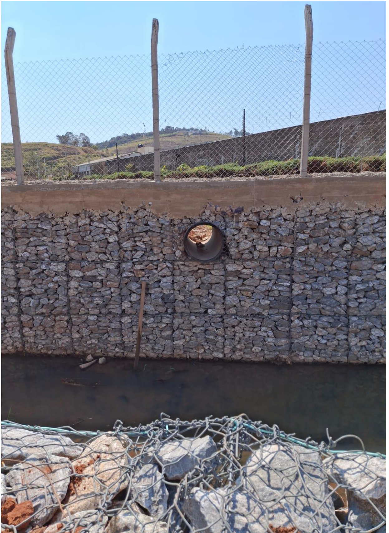
Figura 11 – Descarte pluvial na margem esquerda
