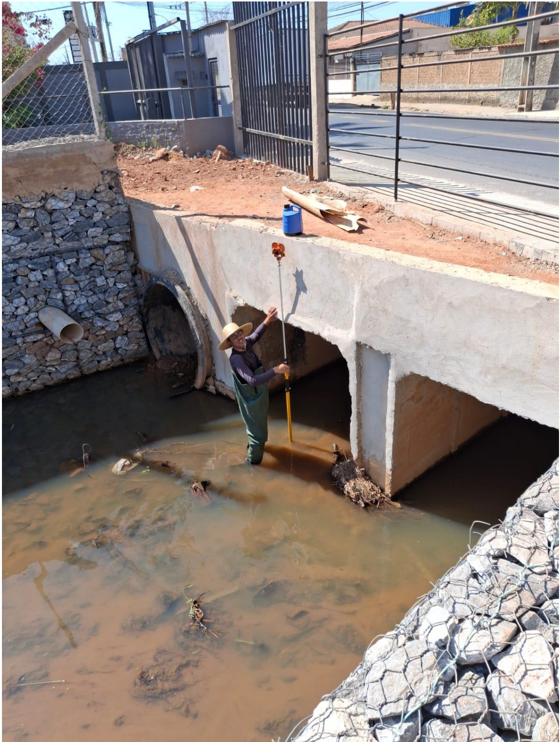
Figura 30 – Coleta de cota fundo do início do bueiro celular
