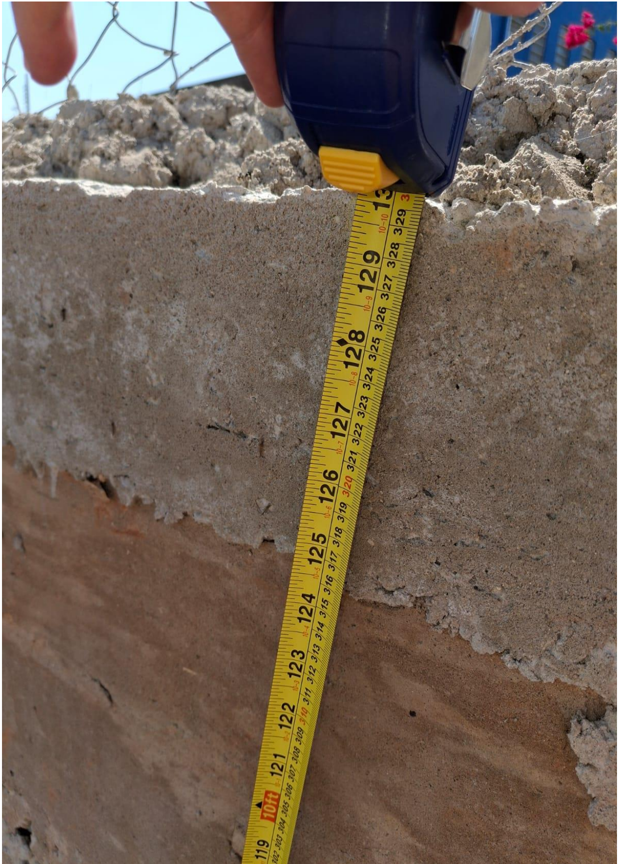
Figura 19 – Medição da altura da parede de gabião na margem esquerda
