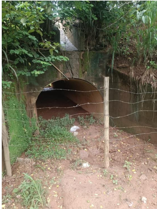
Figura 01 – Na fotografia A, temos o bueiro simples tubular, onde atualmente não apresenta fluxo de água devido ao baixo volume e em B, a vazão de água que escoar pelo bueiro duplo tubular.
