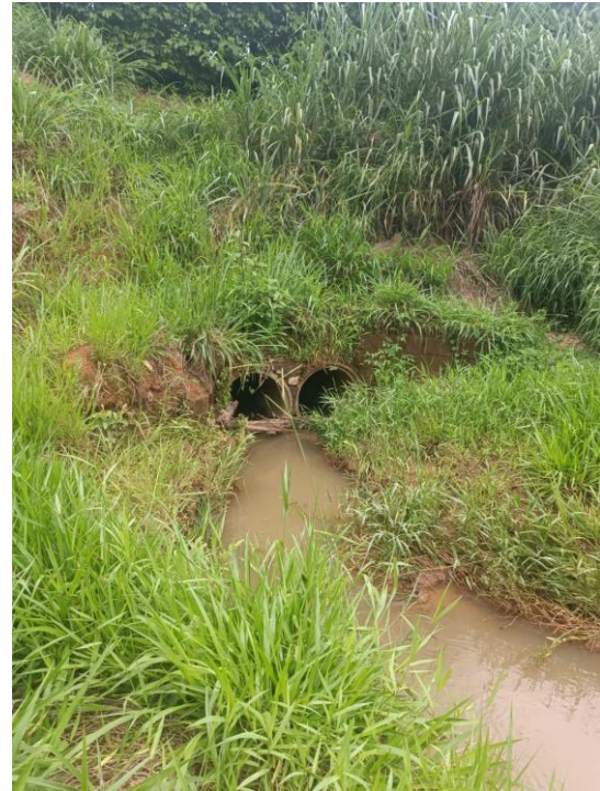
Figura 01 – Na fotografia A, temos o bueiro simples tubular, onde atualmente não apresenta fluxo de água devido ao baixo volume e em B, a vazão de água que escoar pelo bueiro duplo tubular.
