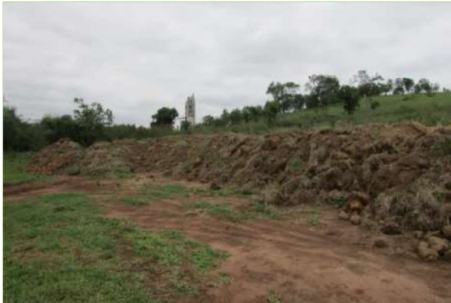
Foto 10: Camada orgânica estocada e reservada para replantio da área a recuperar.
