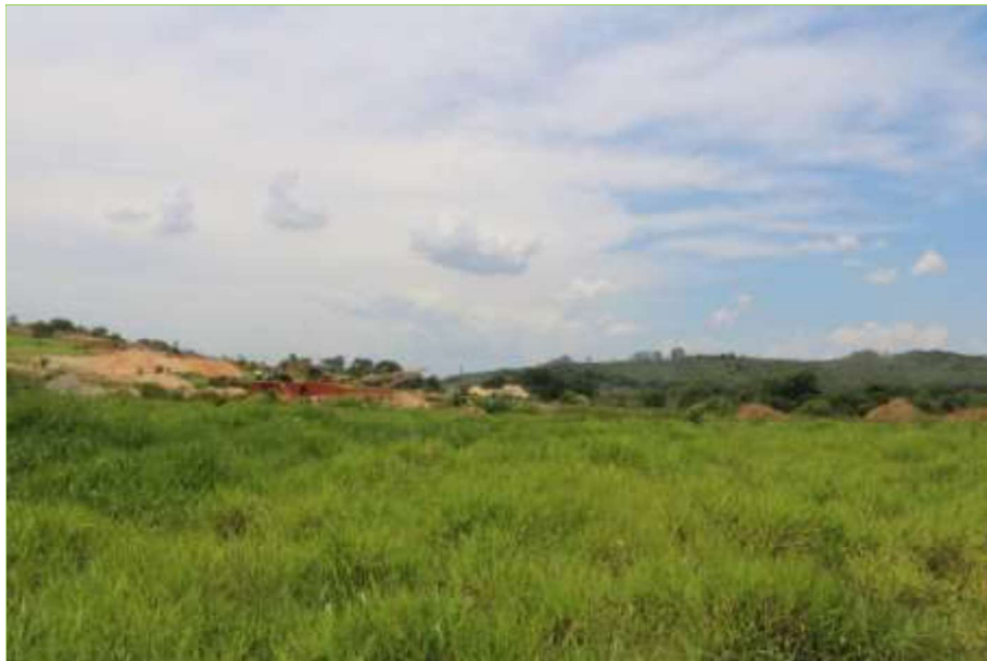
Foto 14: Área com topografia reconstituída, solo orgânico reposto e gramíneas reimplantadas.
