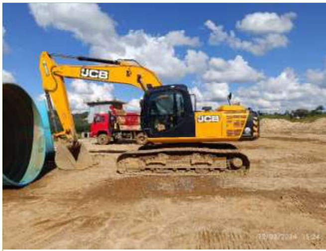
Foto 5: Escavadeira sobre esteira rotatória utilizada no empreendimento.
