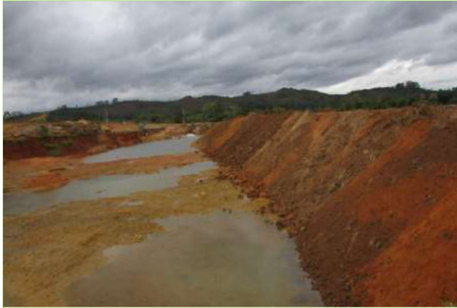
Foto 12: Início de recomposição topográfica de cava/tira exaurida.
