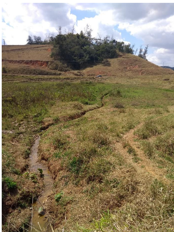
Figura 9 - Foto do leito natural do córrego que será desviado
