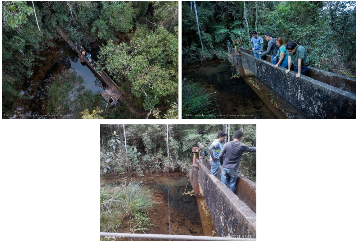
Figura 2 - Área da intervenção
