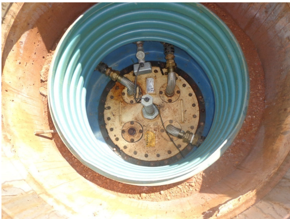
Bocas de visita com sump e fiação com instalação de monitoramento intersticial
