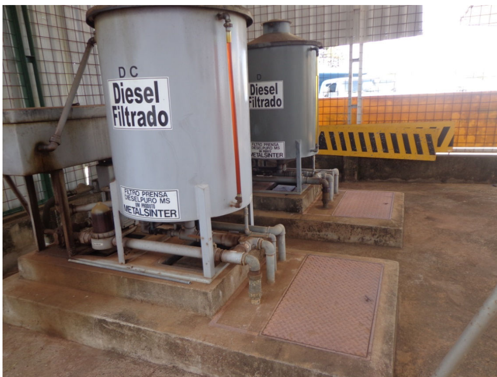
Filtros de diesel dotados de câmaras de contenção.
