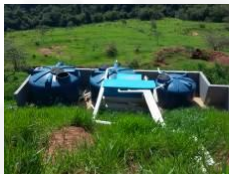
Foto 04. Tanques de recebimento de efluentes antes de lançamento na rede pública.
