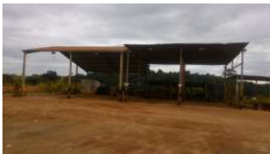
Foto 05: Canteiro de Obras
