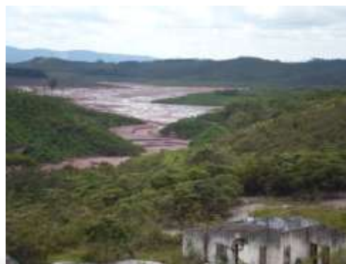
Foto 06: Barragem de rejeitos
