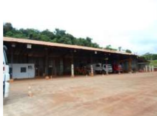
Foto 04: Canteiro de Obras
