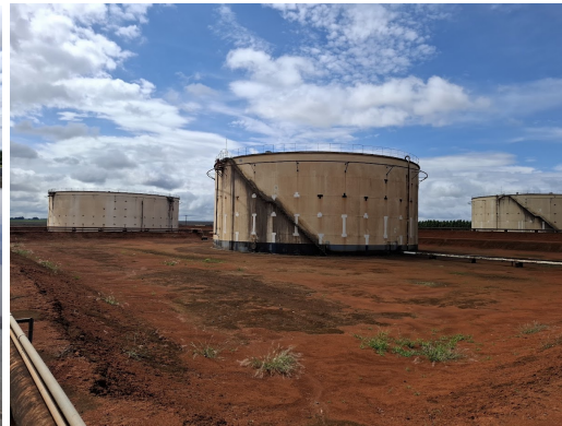
Foto vistoria: Tanques de Etanol
