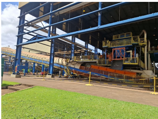
Foto Vistoria: Área industrial
