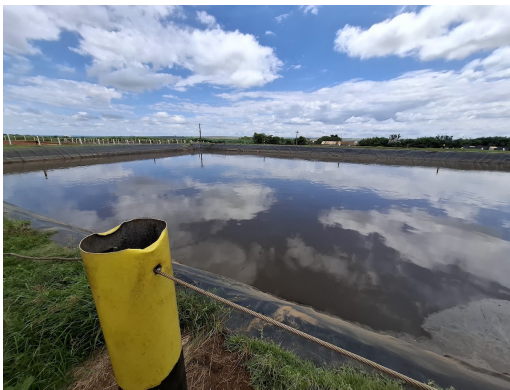
Foto Vistoria: Reservatório de água
