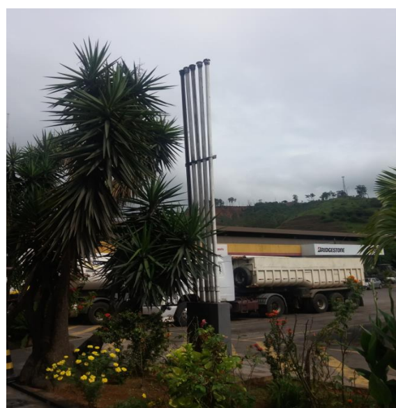
Foto 04: Respiros dos tanques subterrâneos.
