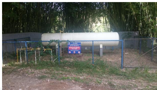
Figura 6 - Base de armazenamento de GLP com capacidade de 7 m 3
