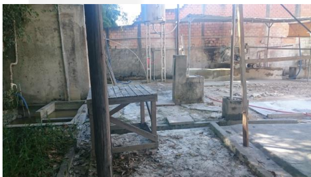
Figura 9 - Canaletas e tanques de sedimentação
