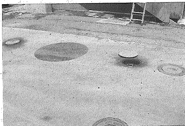
Foto 2: Área de descarga de combustíveis.
