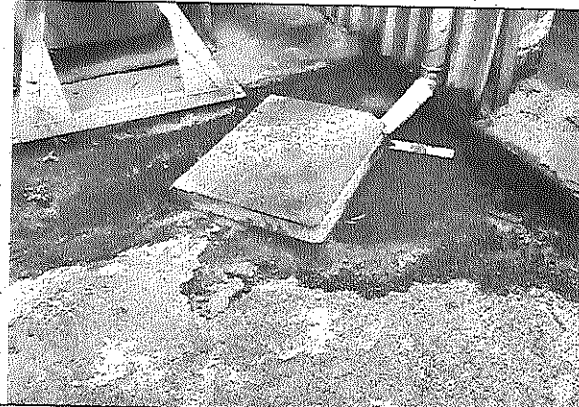
Foto 4 – Adequação do sistema de drenagem pluvial
