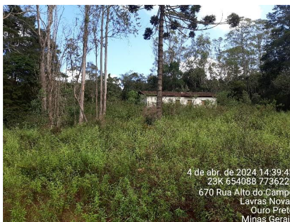
Foto 15: Casa abandonada localizada na área mapeada como "Estabelecimento Rural" que corresponde a uma das estruturas associadas ao antigo viveiro de mudas.
