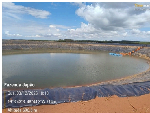
Foto 02. Vista reservatório Off Stream
