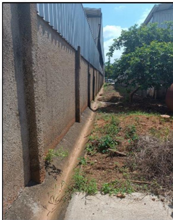
Foto 3: Sistema de coleta de água pluvial
