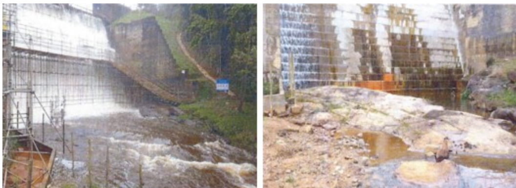
Figura 4 - À esquerda, barramento em obras em dezembro de 2018. À direita, barramento já sem obras em setembro de 2019. Fonte: Siam nº 0771865/19.
