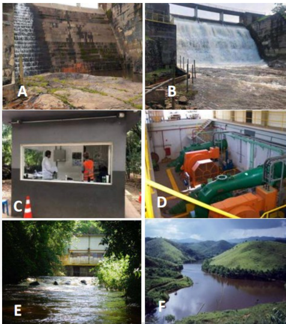
Figura 2 - Fotografias ilustrativas das estruturas civis da PCH Mello: A) Barramento e vertedouro em época de seca; B) Barramento e vertedouro em época de cheia; C) Portaria; D) Turbinas geradoras Reservatório; E) Casa de força e canal de restituição; F) Reservatório. Fonte: Rio Novo Energias Renováveis Ltda. e FEAM.
