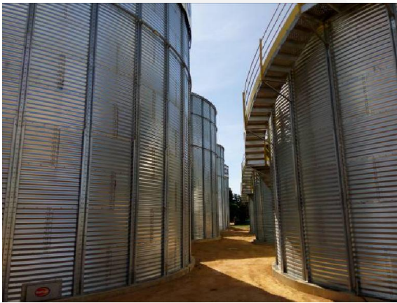
Foto 01. Silos de armazenamento de grãos.
