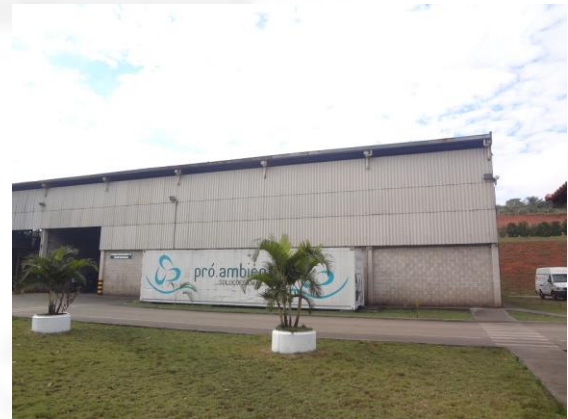
Foto 02. Vista frontal do galpão.
