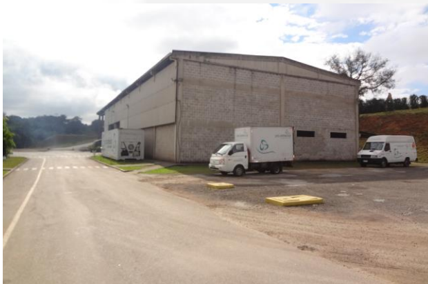
Foto 01. Vista geral do galpão onde será instalado o equipamento.
