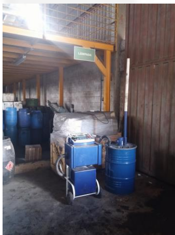
Foto 03. Vista interna ampla da área onde será instalado o equipamento.
