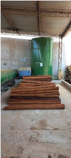
Foto 01. Área de cura da madeira tratada, e armazenamento de produtos químicos.
