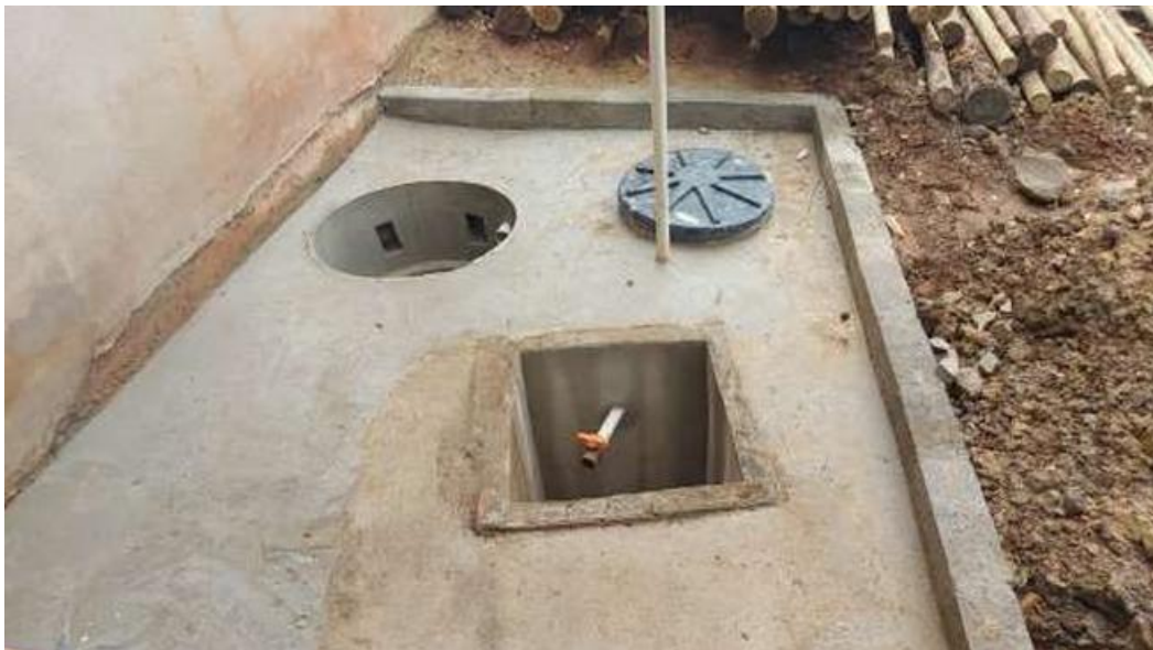
FIGURA 03. Vista do Sistema de Tratamento de Efluentes Sanitários (Biodigestor, Caixa Seca e Sumidouro). Fonte: Laudo Técnico apresentado em cumprimento da informação complementar
