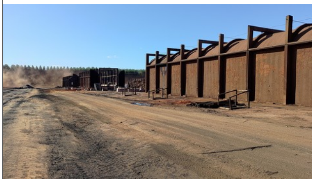
Foto 06. Sistema de captação e armazenamento de água de chuva.
