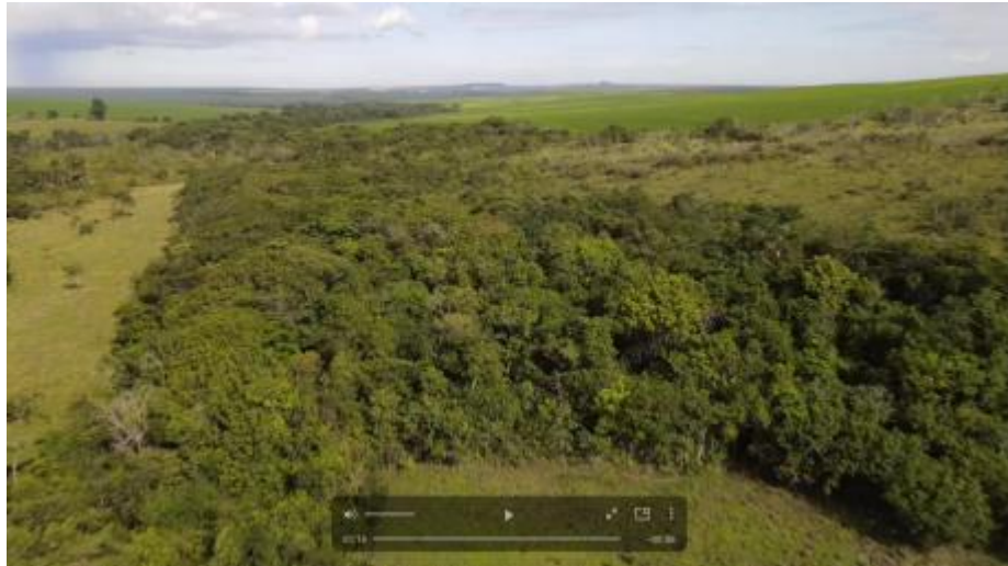
Figura 02. Vista a jusante da barragem projetada.
