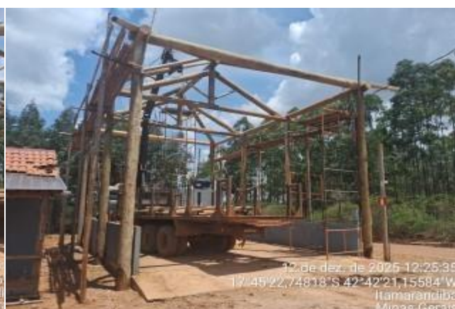
Foto 06. Galpão de manutenção.
