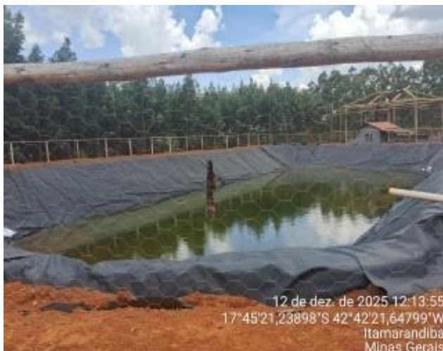
Foto 15. Tanque de armazenamento de água
