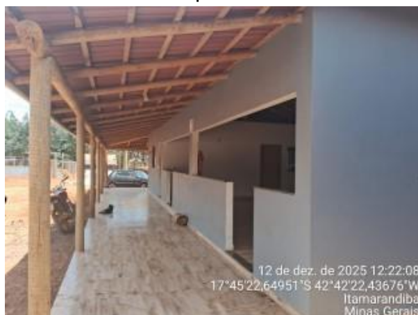
Foto 03. Refeitório, banheiros, sala de descanso, cozinha e área.
