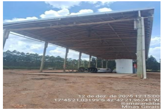
Foto 08. Galpão de tratamento.
