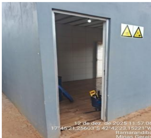
Foto 14. Galpão de armazenamento de CCA
