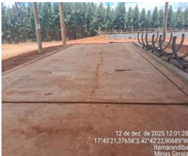
Foto 13. Área de cura da madeira tratada
