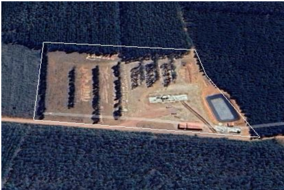
Figura 1: Área Diretamente Afetada – Reginaldo Vieira Gomes
