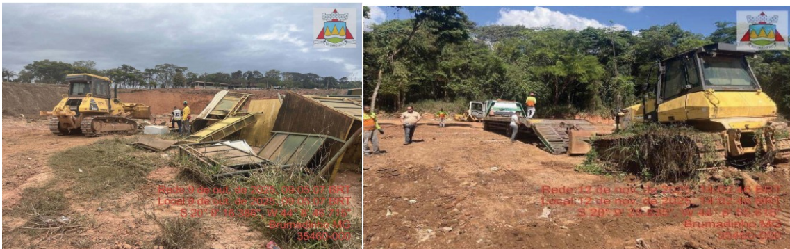
Imagens 14 e 15: Retirada das sucatas
