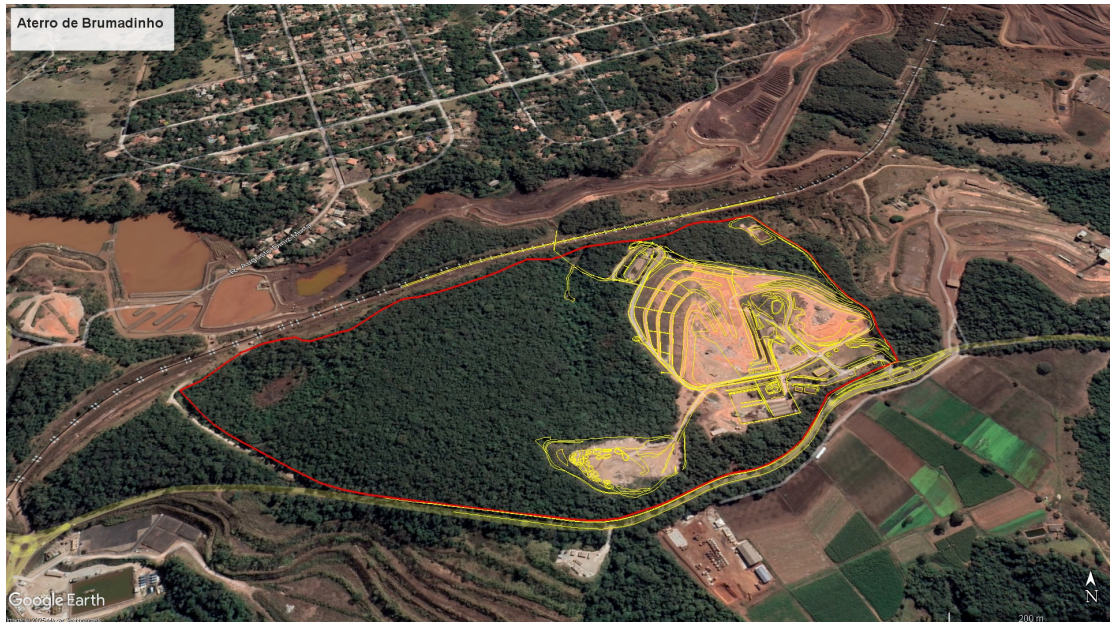
Imagem 01: Área do empreendimento
