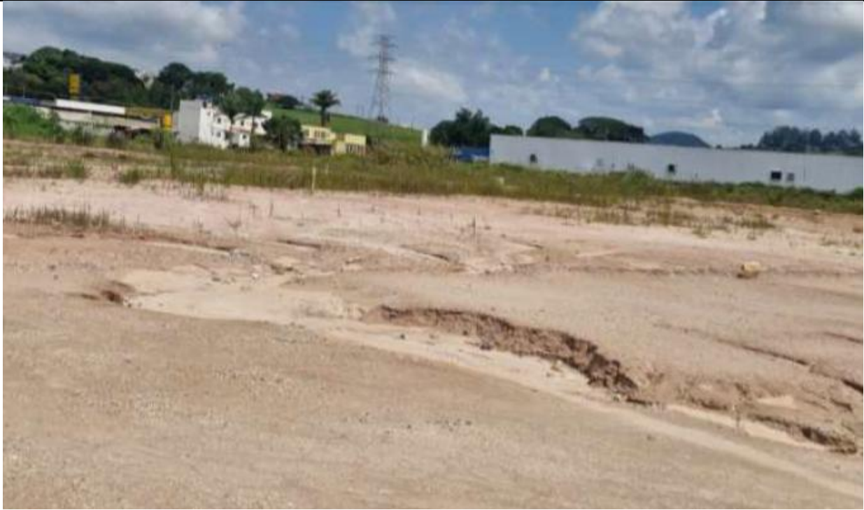
Figura 3 – Presença de sulcos erosivos no terreno. Fonte: RAS
