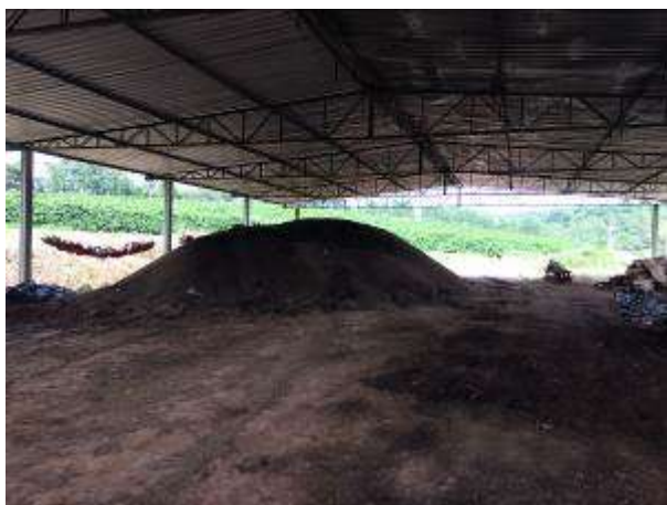
Figura 1 – Galpão de estocagem do adubo
