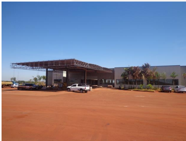
Foto 01. Pista de abastecimento de veículos de pequeno porte - 01
