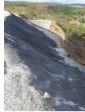
16. Manta Biotextil sobre a pilha de material fino
