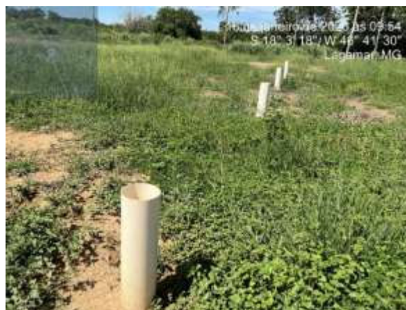
Figura 14: Valas de infiltração e respiros.
