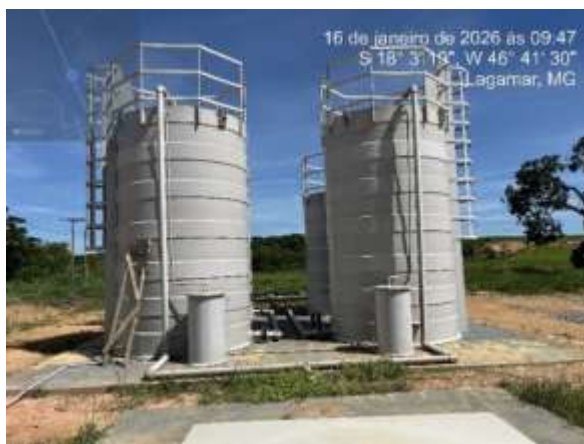
Figura 12: Reatores UASB.
