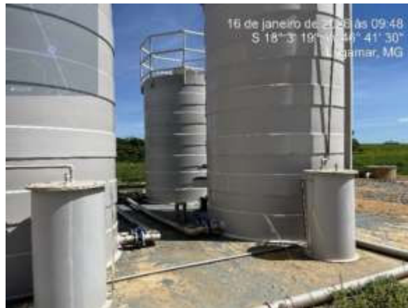
Figura 13: Filtros Anaeróbios.
