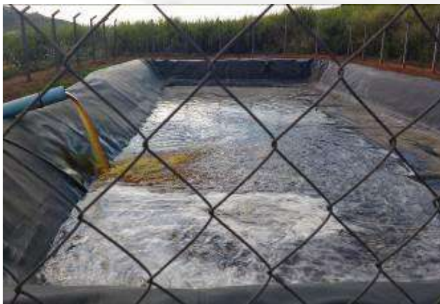
Foto 03. Lagoa de armazenamento de Efluente Industrial
