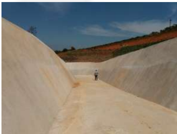
Fotos 3 e 4: Vertedouro edificado para suportar o alteamento da barragem.
