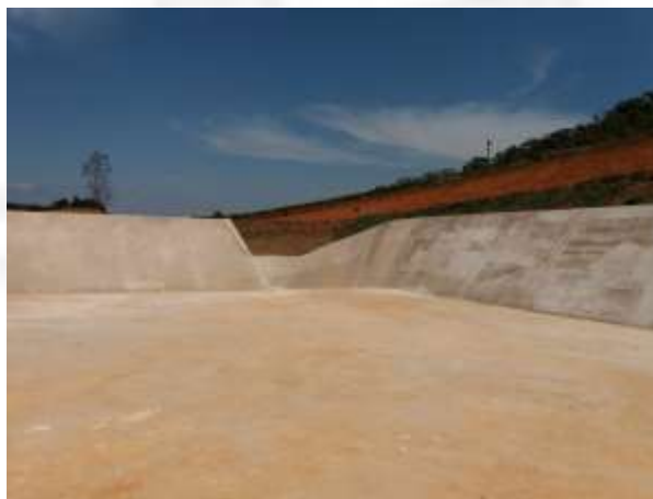
Fotos 3 e 4: Vertedouro edificado para suportar o alteamento da barragem.
