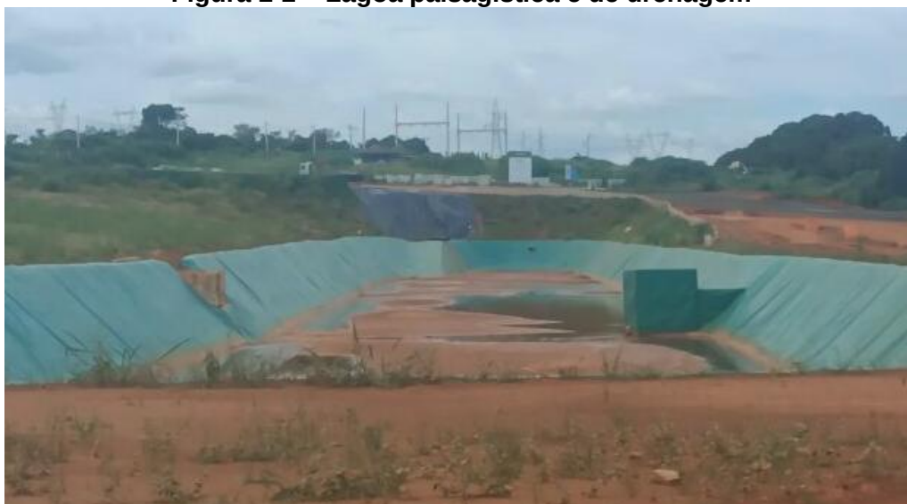
Figura 2-2 – Lagoa paisagística e de drenagem
