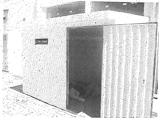
Foto 02. Depósito de resíduos comuns
