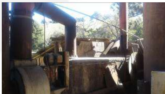
Foto 04. Lavador de gases provenientes da caldeira a lenha.
