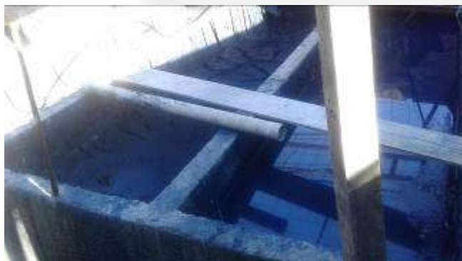
Foto 03. Leito de secagem após tratamento do efluente industrial – lodo gerado.
