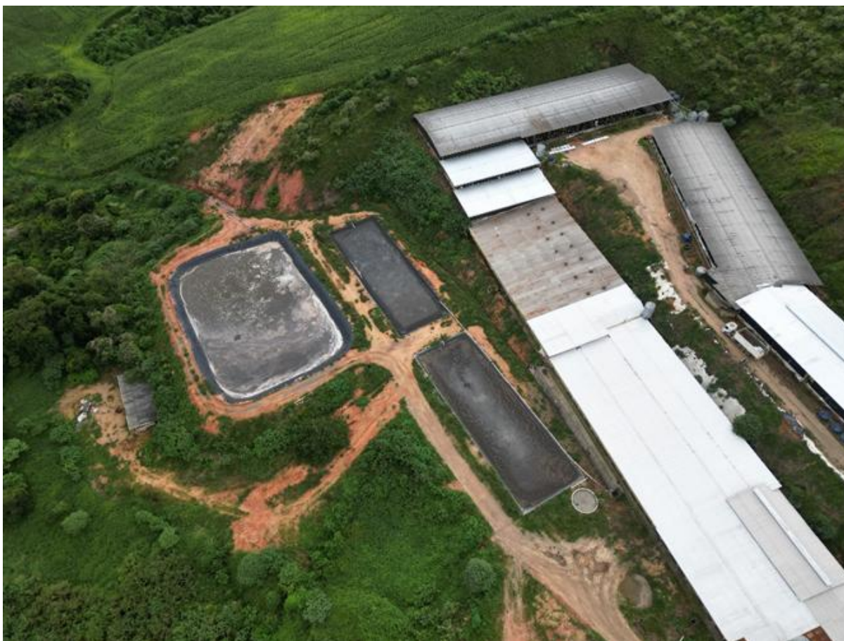
Figura 5: Sistema atual de tratamento do empreendimento. Fonte: ato fiscalizatório “in loco”.
