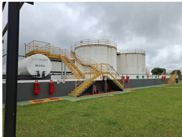
Foto vistoria: Tanques posto de combustíveis
