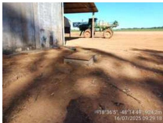
Foto 2. Caixa Separadora de Água e Óleo – CSAO (ausência de instalação de sumidouro).
