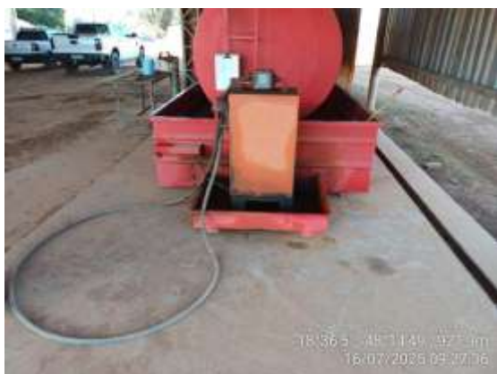
Foto 1. Área de abastecimento de combustível (ausência de canaletas de drenagem no entorno de toda a área).
