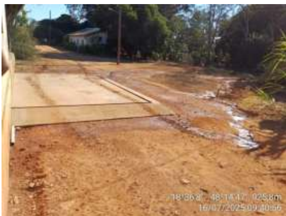
Foto 1. Área de abastecimento de combustível (ausência de canaletas de drenagem no entorno de toda a área).
