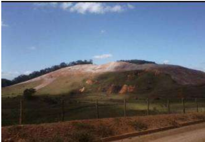
Figura 14: Calagem aplicada em uma área reabilitada.
