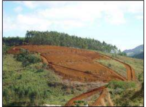
Figura 6: Decapeamento no corpo 147, DNPM 830.740/80.
