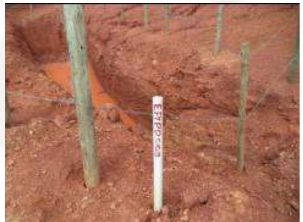
Figura 8: Identificação de poço de decantação cadastrado para inspeção.
