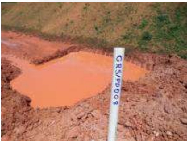
Figura 7: Poço de decantação em áreas de lavra.
