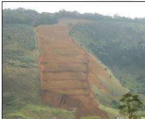
Figura 13: Abertura de curvas de nível, nas áreas em conformação.
