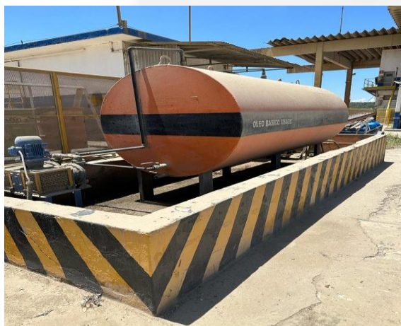
Foto 10 – Armazenamento óleo usado
