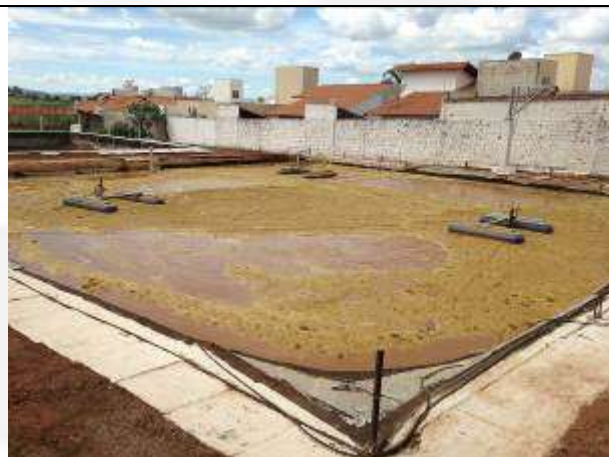
FOTO 04. Tanque do tratamento de Lodo Ativado em Batelada da ETE.
