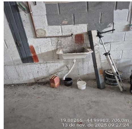
Foto 02. Tanque de limpeza de equipamento e higienização.
