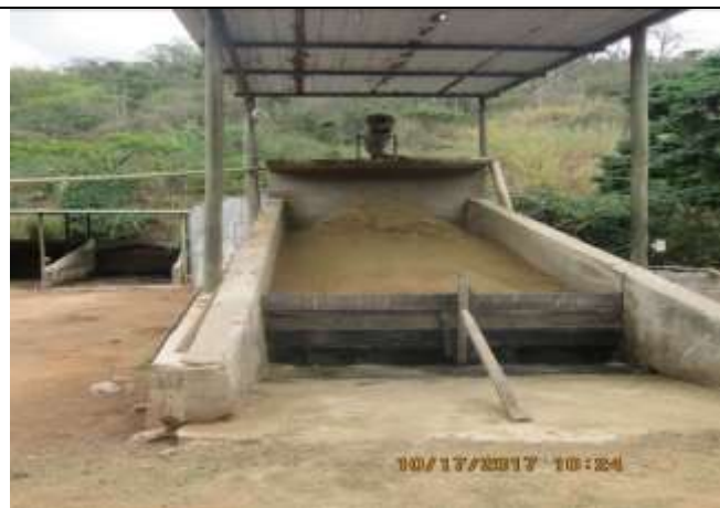
Foto 5: separador de sólido do líquido do efluente da granja (ecofiltro)
