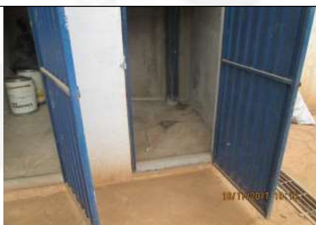
Foto 4: DTR com contenção de vazamento
