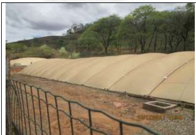
Foto 13: biodigestores
