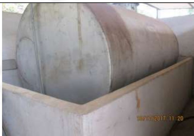
Foto 14: tanque de armazenamento de combustível
