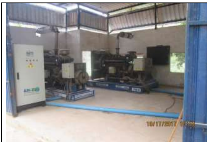
Foto 11: 02 geradores de energia de 330 kVA cada
