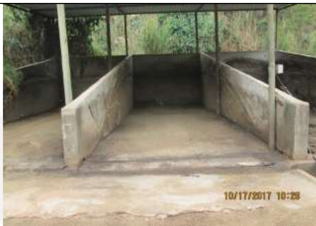
Foto 6: esterqueira que armazena o sólido do ecofiltro
