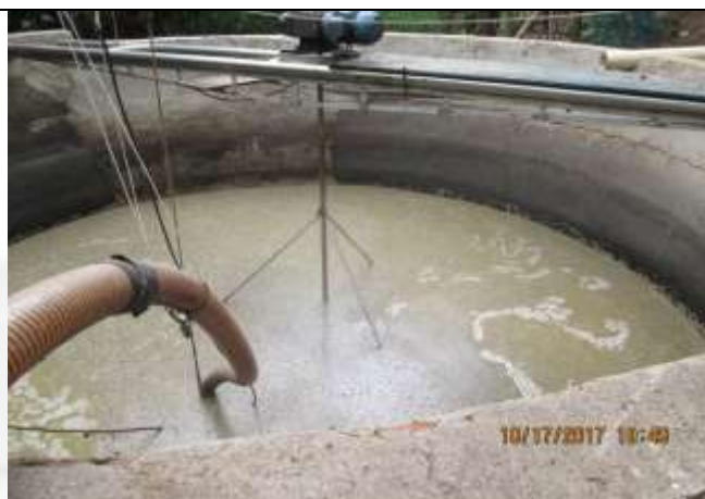
Foto 12: tanque de equalização do efluente da granja
