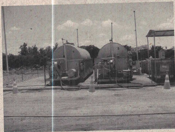
Foto 01. Tanques aéreos e boca de descarga dos tanques subterrâneos (indicado pelos cones)
