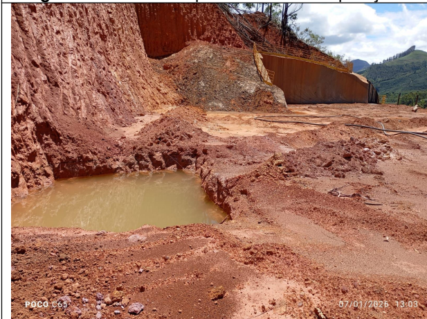
Imagem 03: Vista da frente de lavra e sistema de drenagem
