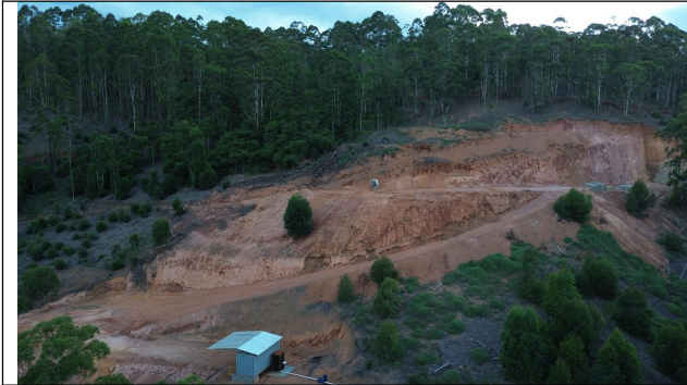
Imagem 01: Vista do empreendimento em operação
