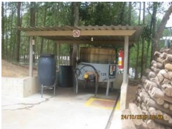
Ponto de abastecimento com canaletas e contenção
