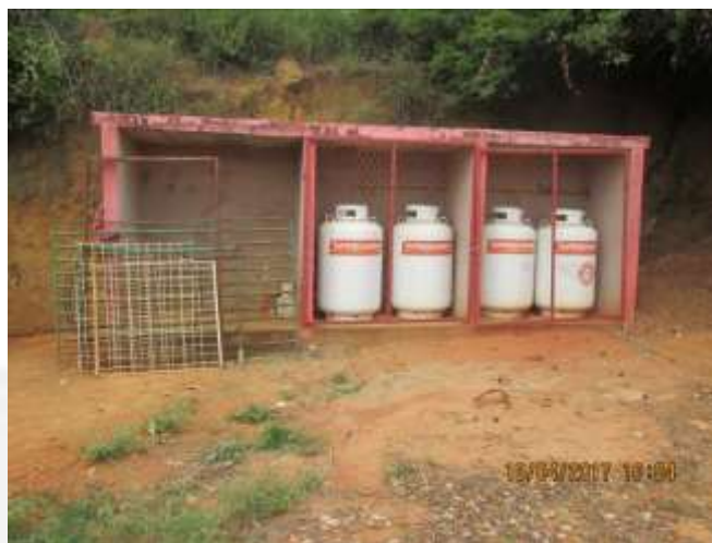
Figura 06: Depósito de GLP.
