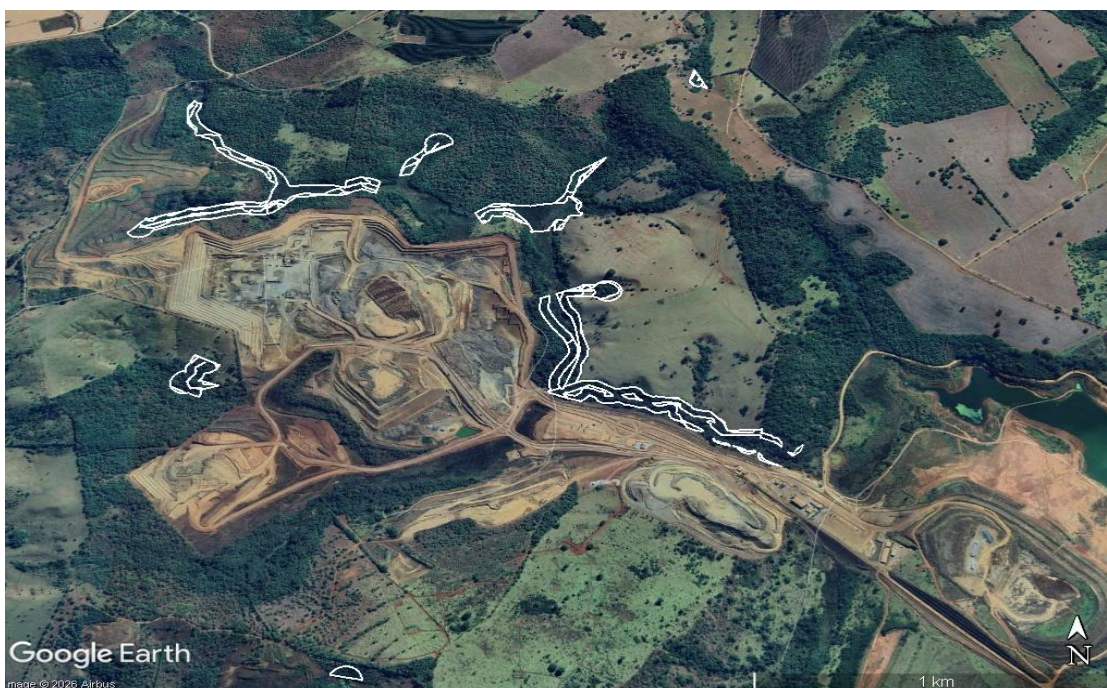
Imagem 05: APP's a serem suprimidas na área da cava
