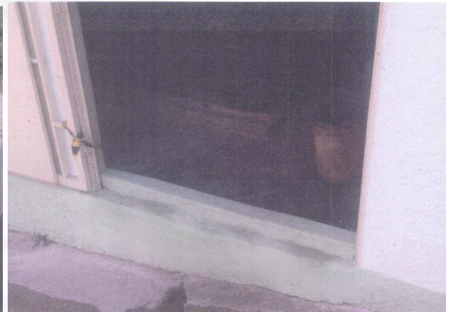
Foto 02. Cômulo onde se encontra o gerador de energia elétrica com bacia de contenção
