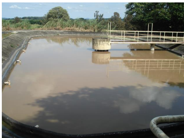
Foto 05. Lagoa de tratamento de efluente líquido.
