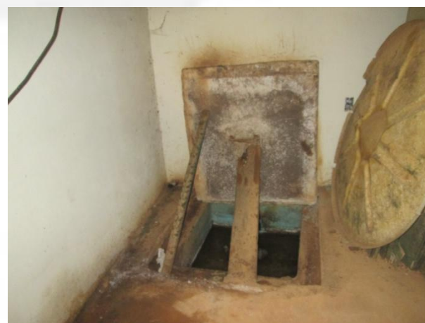
Foto 08. Sistema de fossa séptica/filtro anaeróbio
