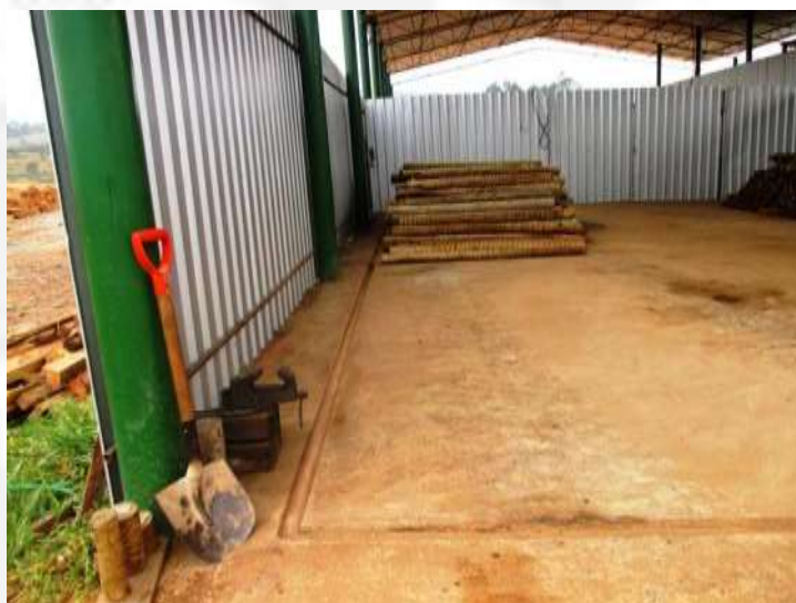
Figura 6 – Local de armazenamento de produto acabado, abrigado, com piso impermeabilizado e com canaletas
