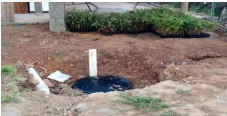
Figura 8 – Fotografia da instalação da fossa séptica
