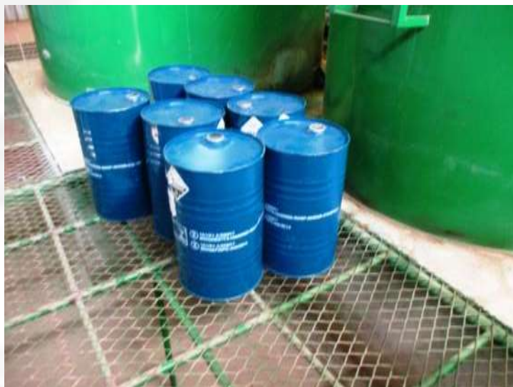
Figura 7 - Local de armazenamento de líquido preservativo (CCA+água)
